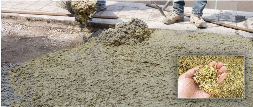
Figura 4 - Uso na Construção Civil de cinzas da casca de arroz (CCA)
