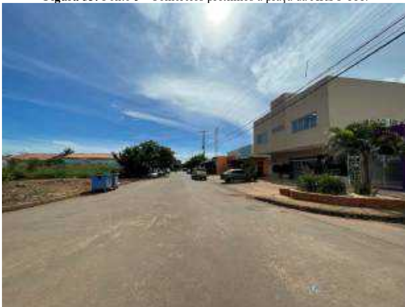
Figura 53: Ponto 5 - Comércio próximos a praça da ARSO 111.
