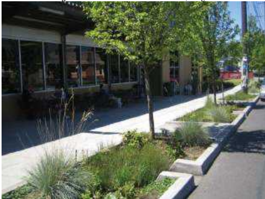
Figura 8: Canteiros Pluviais em Portland, Oregon.
