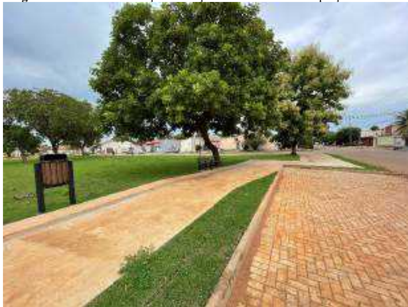
Figura 51: Ponto 3 - Execução de calçadas e estacionamento praça ARSE 111.
