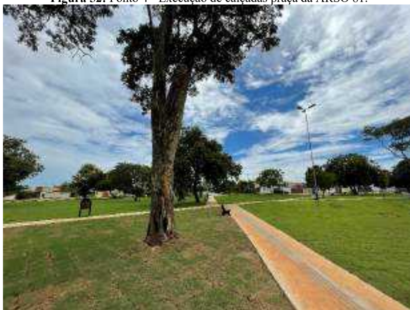
Figura 52: Ponto 4 - Execução de calçadas praça da ARSO 81.
