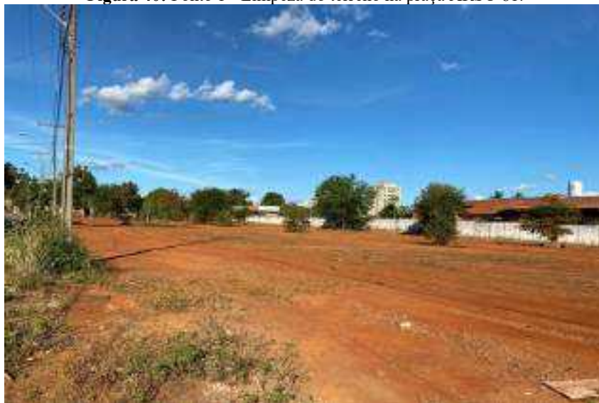
Figura 40: Ponto 1 - Limpeza do terreno na praça ARSO 81.
