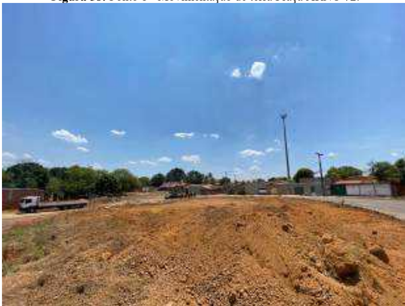
Figura 58: Ponto 1 - Movimentação de terra Praça ARNO 72.
