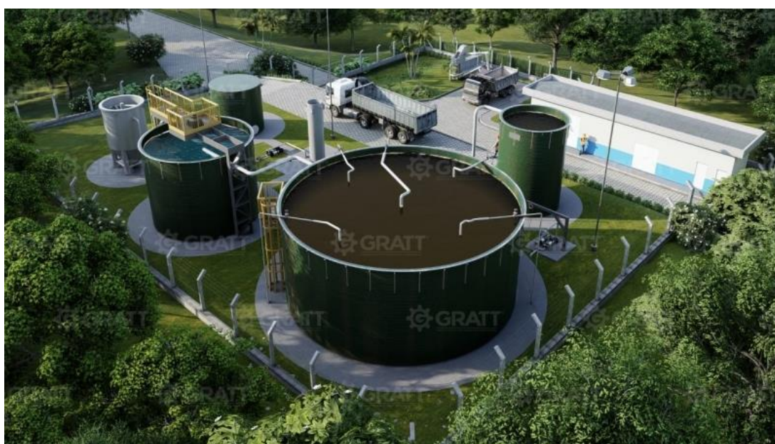
Figura 2 – Sistema de Lodo Ativado
