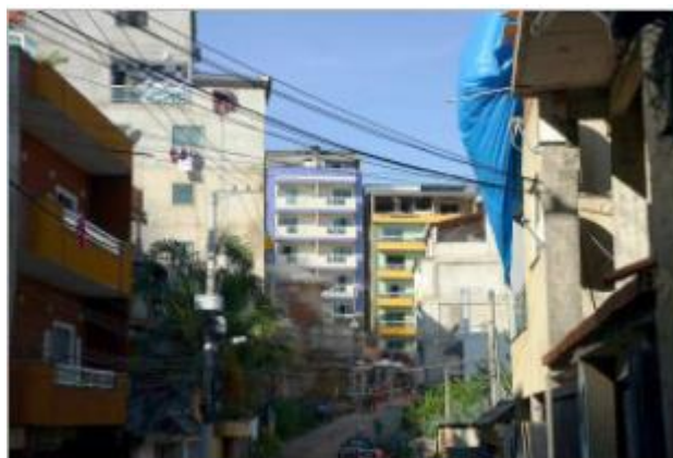
Figura 5 - Prédios construídos irregularmente na região de Muzema, no Rio: desabamentos causaram 24 mortos
