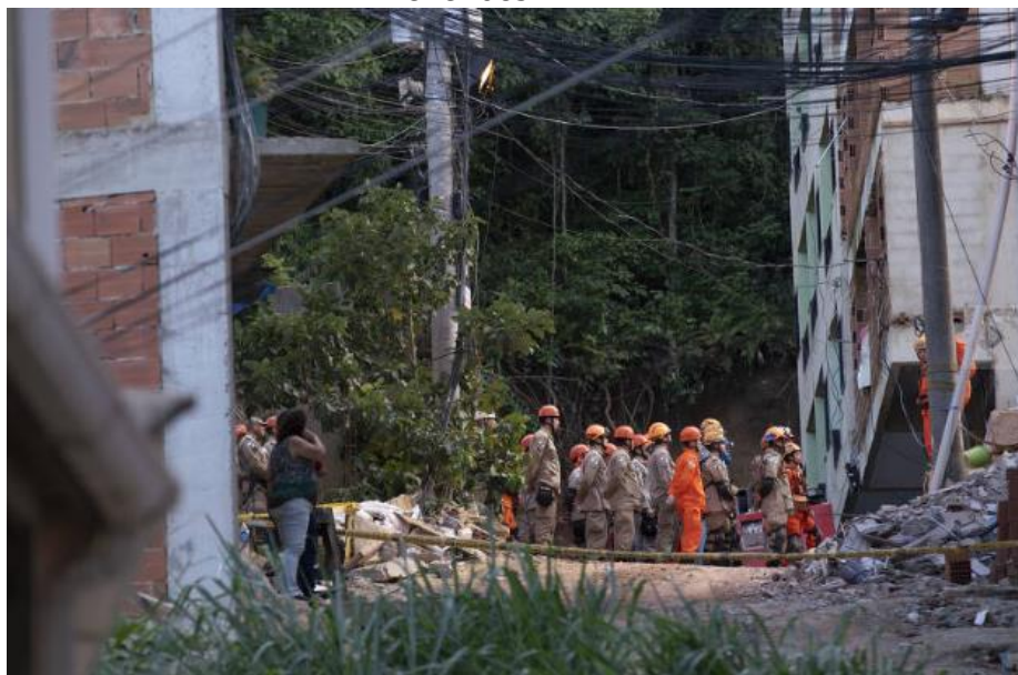
Figura 8 – Construções no bairro da Muzema, onde dois prédios desabaram deixando mortos e feridos
