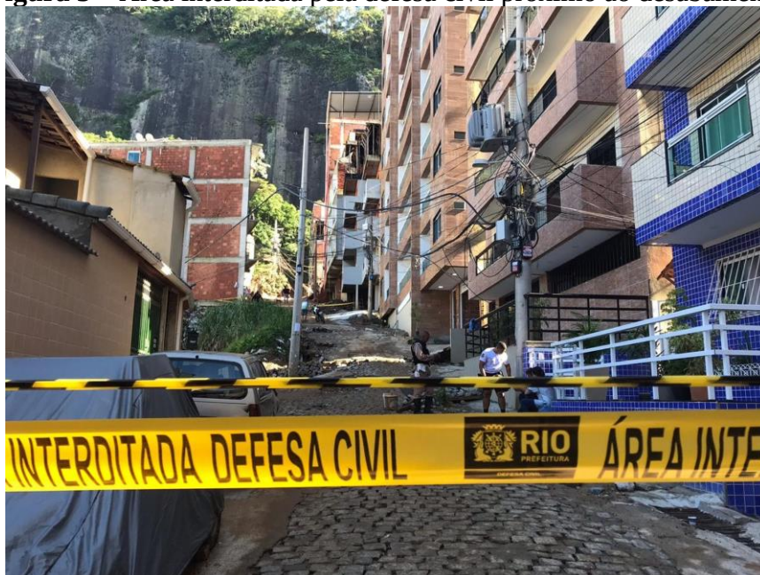
Figura 3 – Área interdita pela defesa civil próximo ao desabamento
