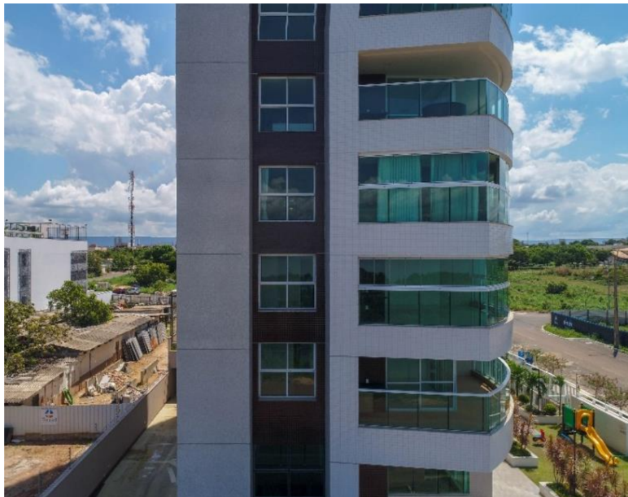
Figura 61 – Panorama fachada frontal projeção cilíndrica no Lightroom Classic
