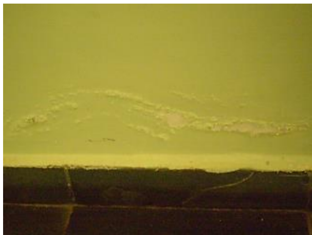
Figura 6 - Vesículas no revestimento
