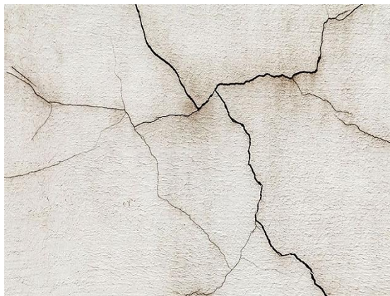
Figura 11 - Fissuras mapeadas
