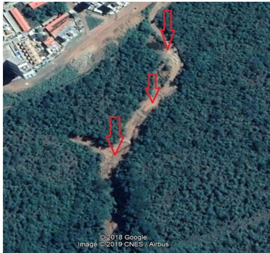
Figura 11 - Voçoroca provocada por erosão hídrica
