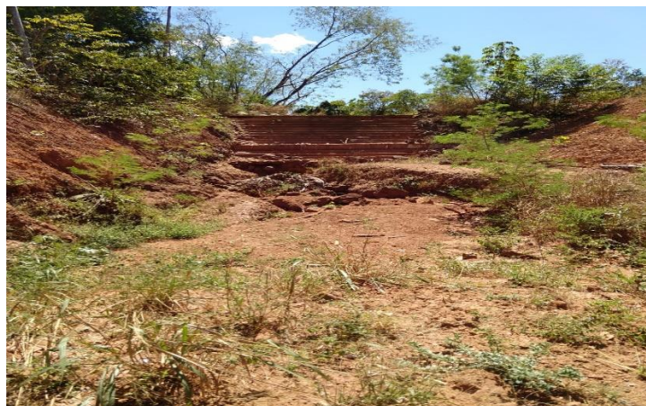
Figura 15 - Vegetação presente nos entornos dos taludes e da área degradada
