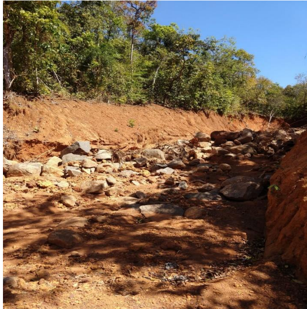
Figura 23 - Paredões de pedra instalados para amortização de energia
