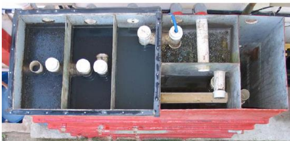
Figura 7 - Vista superior da ETAC da UFES. Fonte: Extraído de Bazzarella (2005)
