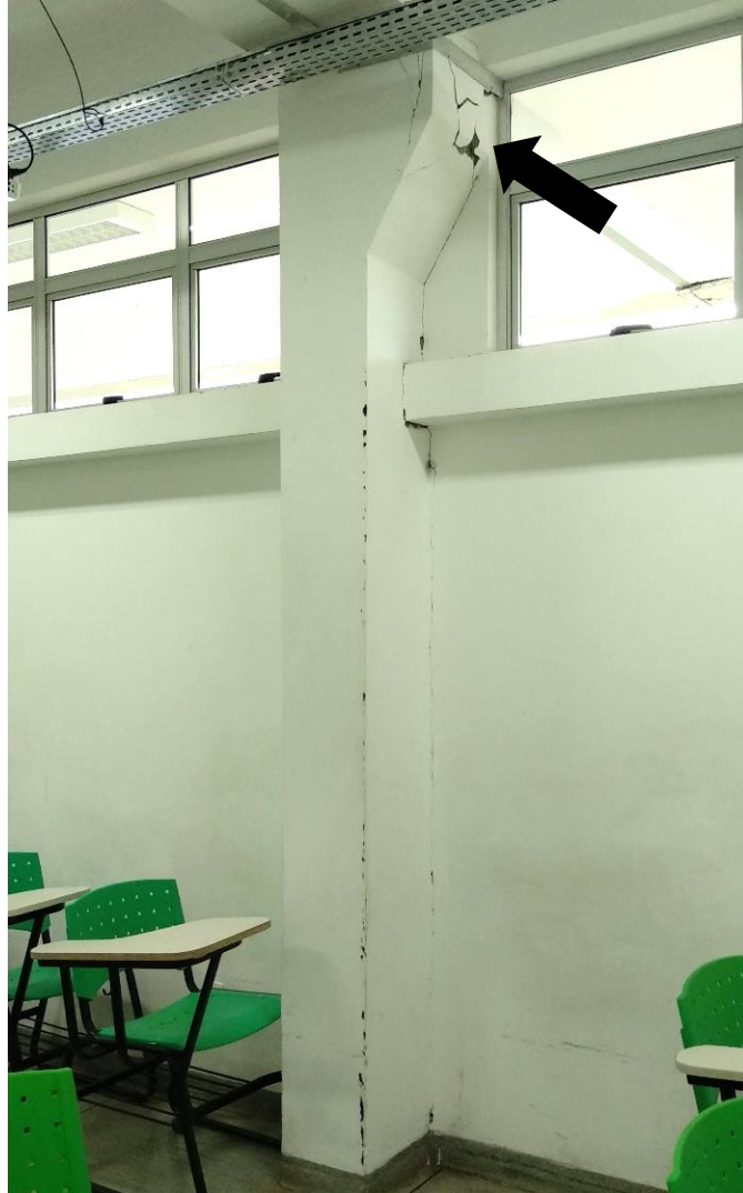
Figura 15 - Esmagamento do concreto
