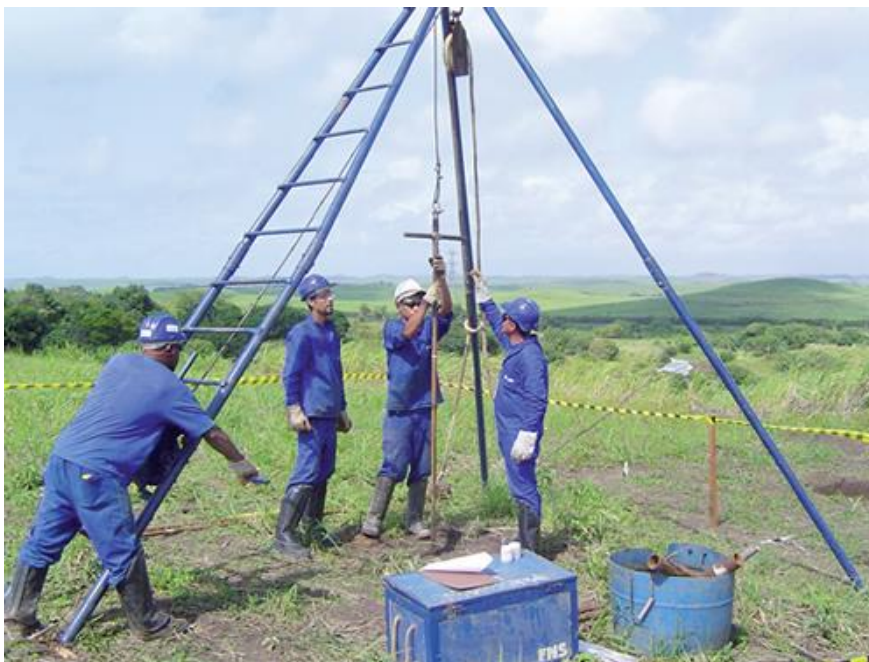
Figura 1 - Equipamentos do ensaio SPT
