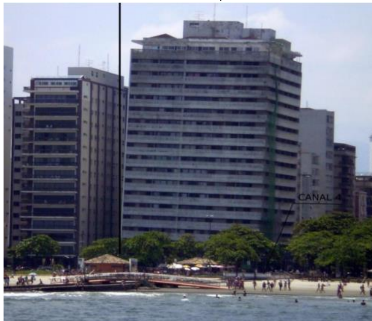
Figura 12 – Edifício Excelsior inclinado, situado na orla de Santos-SP.
