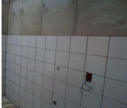
Figura 41 - Revestimento feito diretamente sobre as Paredes de Concreto
