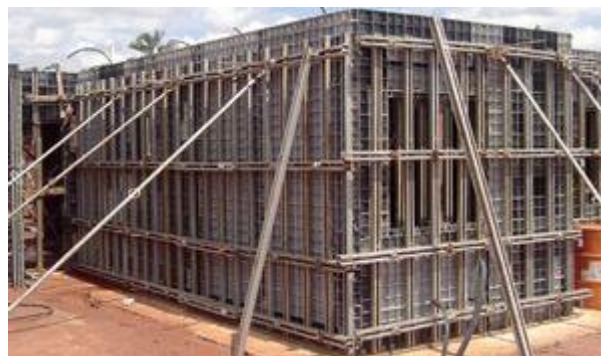
Figura 30 - Posicionamento das escoras prumadoras
