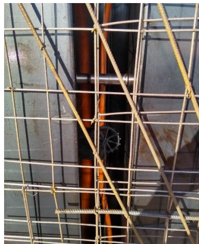
Figura 11 - Detalhe dos espaçadores e das armaduras, neste caso tela eletro soldada
