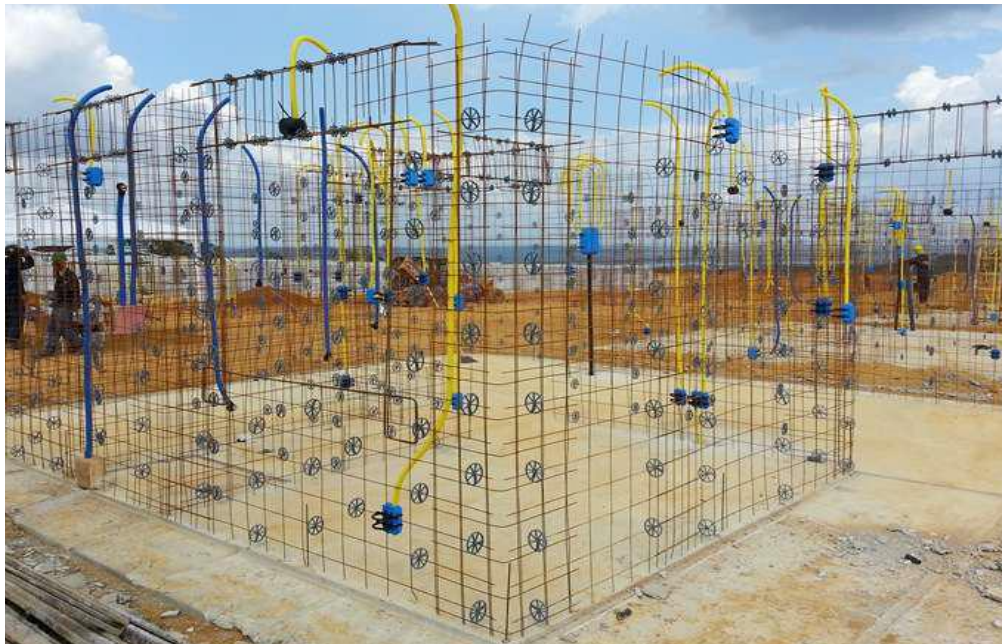
Figura 18 - Montagem da rede elétrica no sistema Paredes de Concreto
