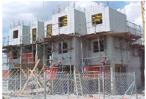
Figura 20 - INPAR - Edifício multipavimentos, após a retirada das fôrmas
