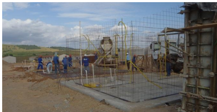
Figura 4 - Fundação em Radier
