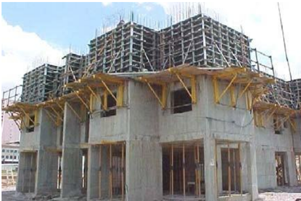
Figura 19 - INPAR - Edifício multipavimentos, escoramento e posicionamento das fôrmas
