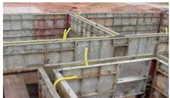
Figura 22 - Fôrmas dos painéis de uma edificação térrea posicionadas, detalhe das instalações elétricas embutidas Analândia-SP
