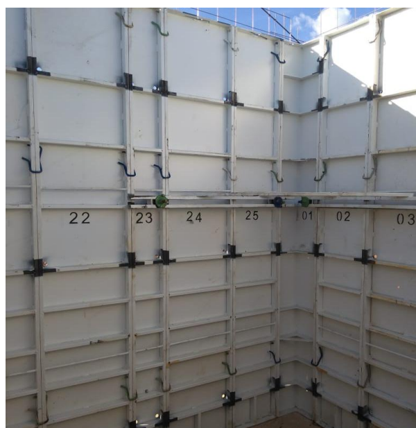
Figura 28 - Numeração dos painéis
