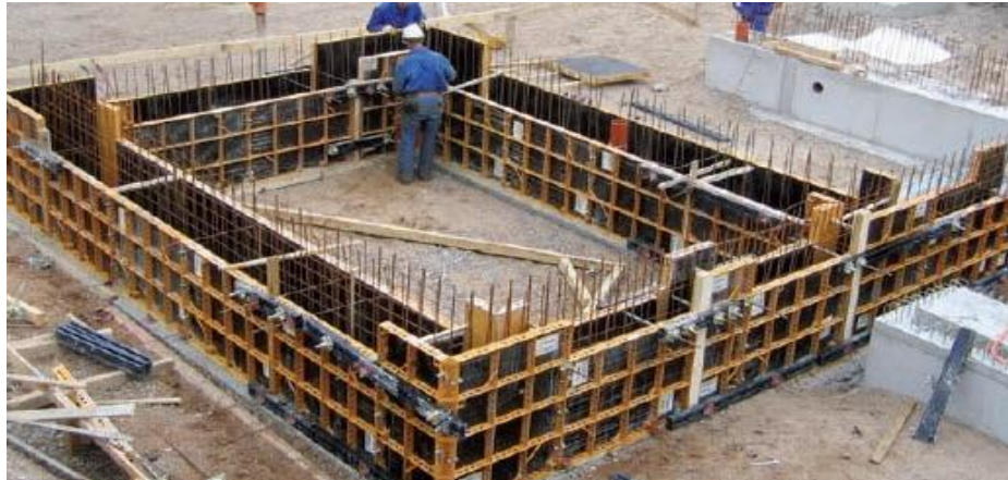
Figura 24 - Fôrma em madeira para execução de parede de concreto
