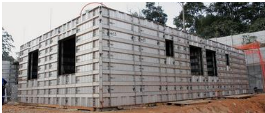
Figura 23 - Execução de parede de concreto com fôrmas metálicas de alumínio
