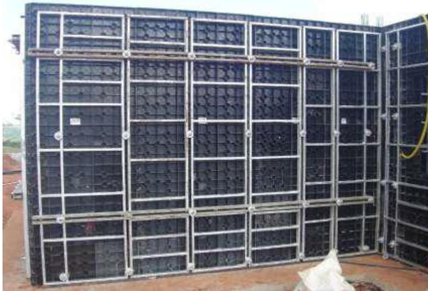
Figura 25 - Fôrma plástica para execução de paredes de concreto
