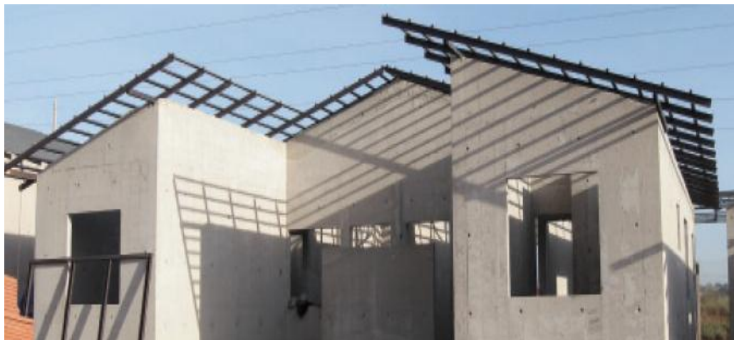
Figura 38 - Sistema de cobertura em estrutura metálica
