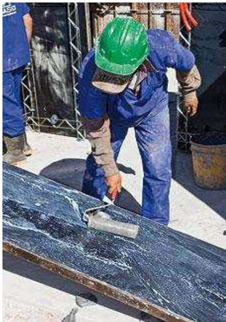
Figura 31 - Aplicação de desmoldante
