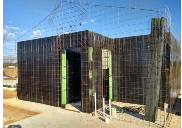
Figura 10 - Armadura posicionada na parede de concreto
