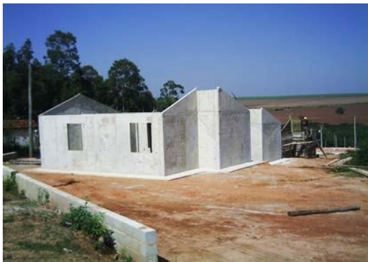
Figura 42 - Vedações após a desforma. Santa Maria da Serra-SP
