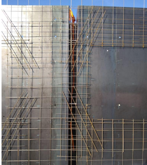
Figura 14 - Posicionamento da armadura
