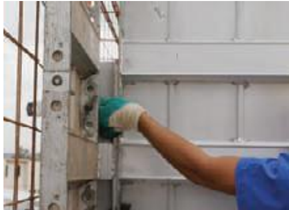
Figura 29 - Colocação dos elementos de costura
