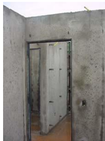
Figura 33 - Detalhe de esquadria após desforma. Analândia-SP
