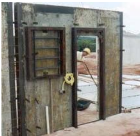
Figura 32 - Painel com esquadrias fixadas. Analândia-SP
