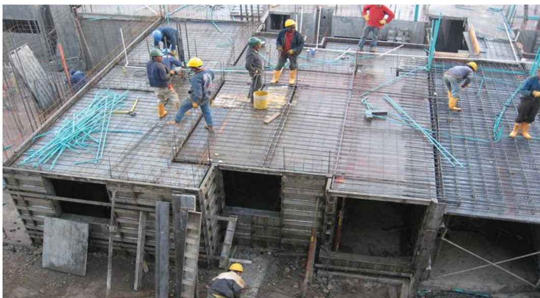
Figura 12 - Posicionamento da armação da laje
