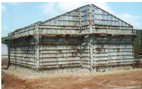
Figura 21 - Visão geral das fôrmas das vedações montadas. Analândia-SP
