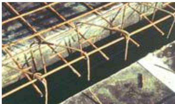
Figura 17 - Ancoragem da armadura na laje
