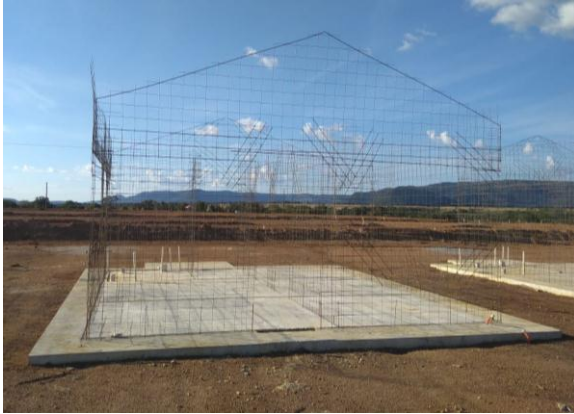
Figura 9 - Posicionamento da armação para as paredes de concreto
