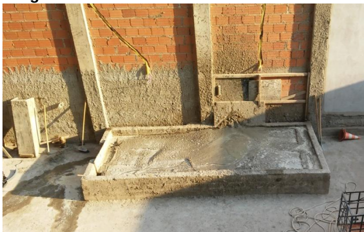
Figura 21 – Baia de armazenamento canteiro 3
