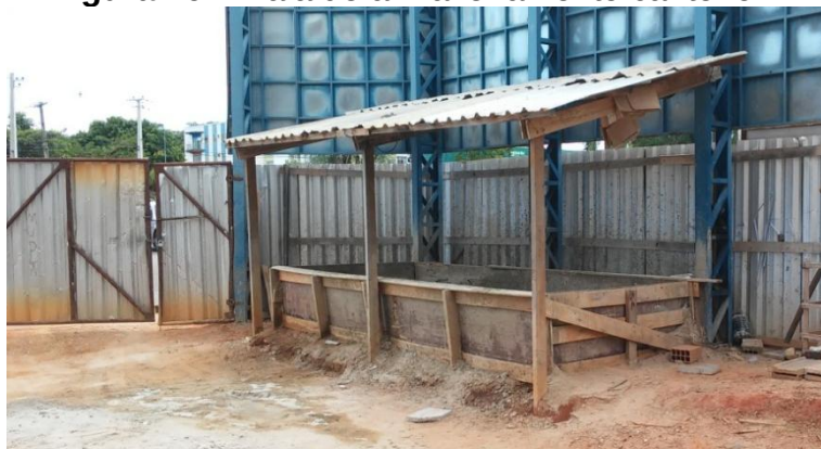
Figura 19 – Baia de armazenamento canteiro 1
