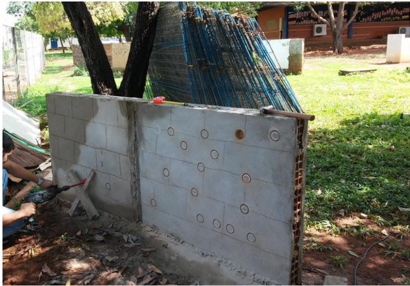
Figura 13 – Painel com os cortes já realizados e com marcação das juntas
