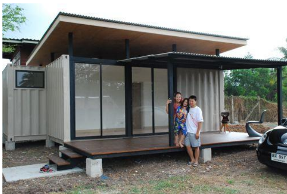
Figura 29 - Construção em container coberta por uma grande laje, proporcionando ventilação entre o container e a cobertura
