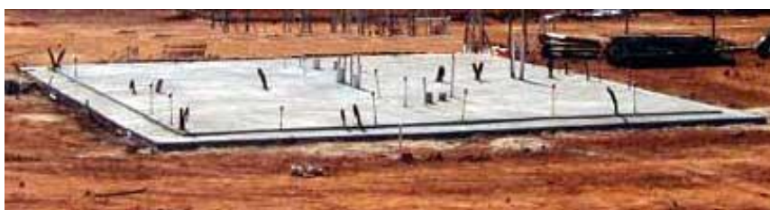
Figura 17 - Laje radier concretada com as esperas das instalações.
