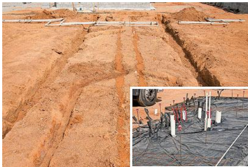
Figura 16 - Terreno nivelado e preparado com as esperas das instalações.
