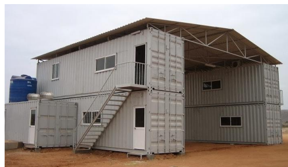
Figura 28 - Galpão em container, com cobertura inclinada
