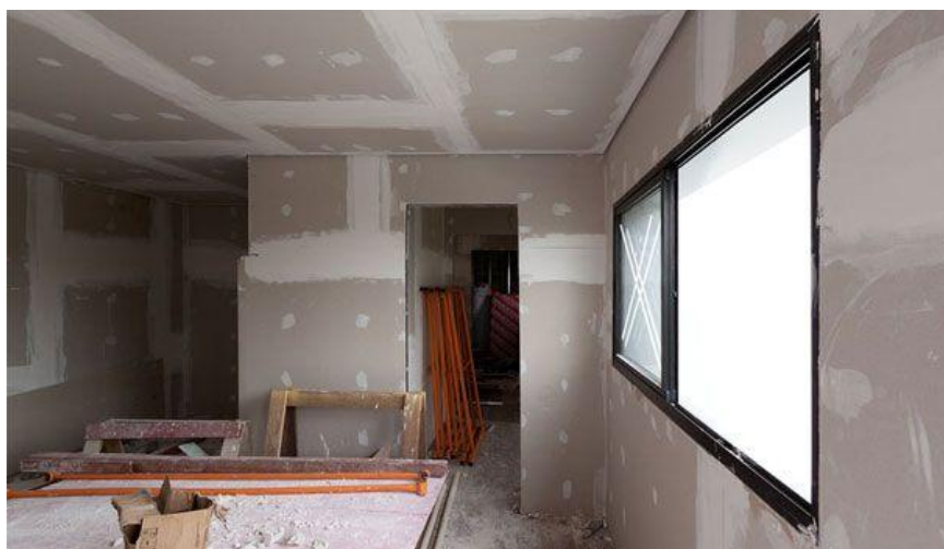
Figura 73 - Fase de acabamento, paredes e forro em drywall instalados.
