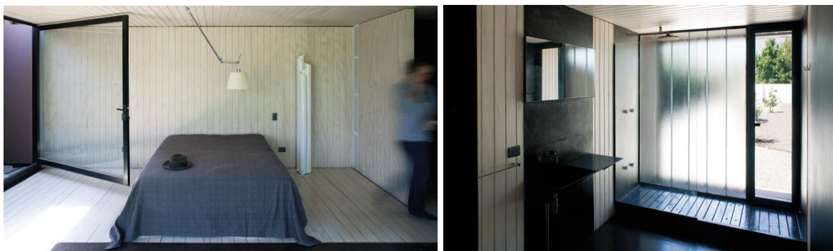
Figura 54 - Detalhes da parte interna da edificação toda revestida em compensado de pinus.
