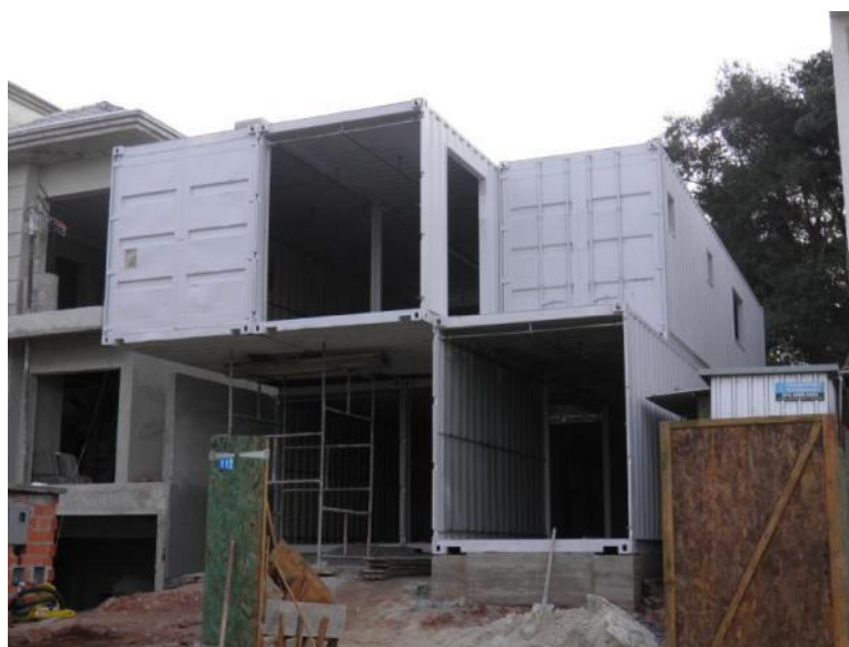
Figura 71 - Em fase de construção, casa de alto padrão em Curitiba-PR.
