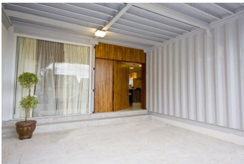
Figura 75 - Garagem da casa container.
