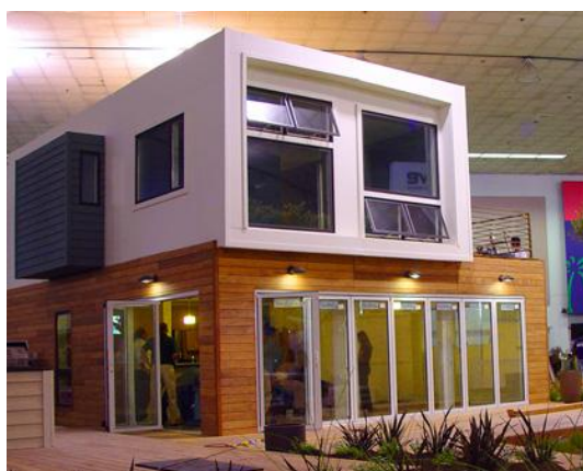
Figura 46 - Acabamentos normalmente utilizados em construções convencionais também podem ser utilizados em construções com container Fonte: Site construindo.org
