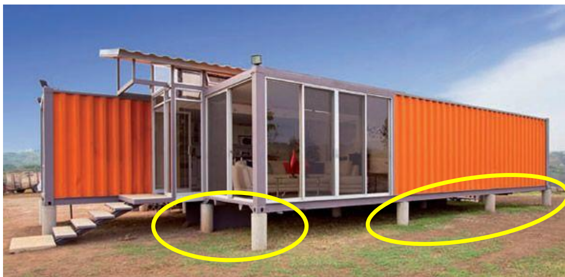
Figura 20 - Casa suspensa do solo com pilaretes a mostra.
