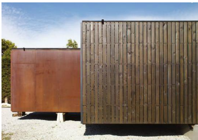
Figura 53 - Painéis de revestimento externo em aço corten e pinus.
