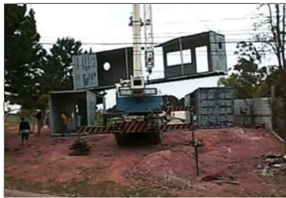
Figura 23 - Containers sendo dispostos no terreno, com uso de guindaste Fonte: Site Editora Pini
