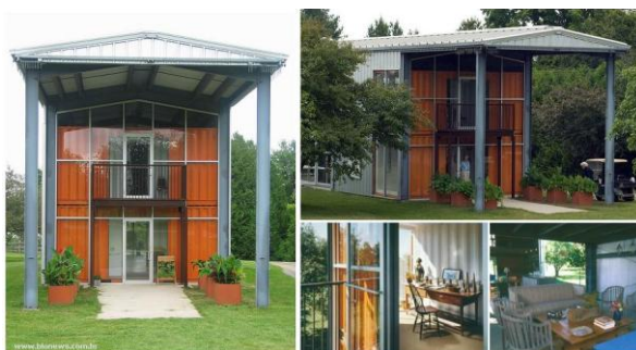
Figura 27 - Cobertura inclinada em construção em container
