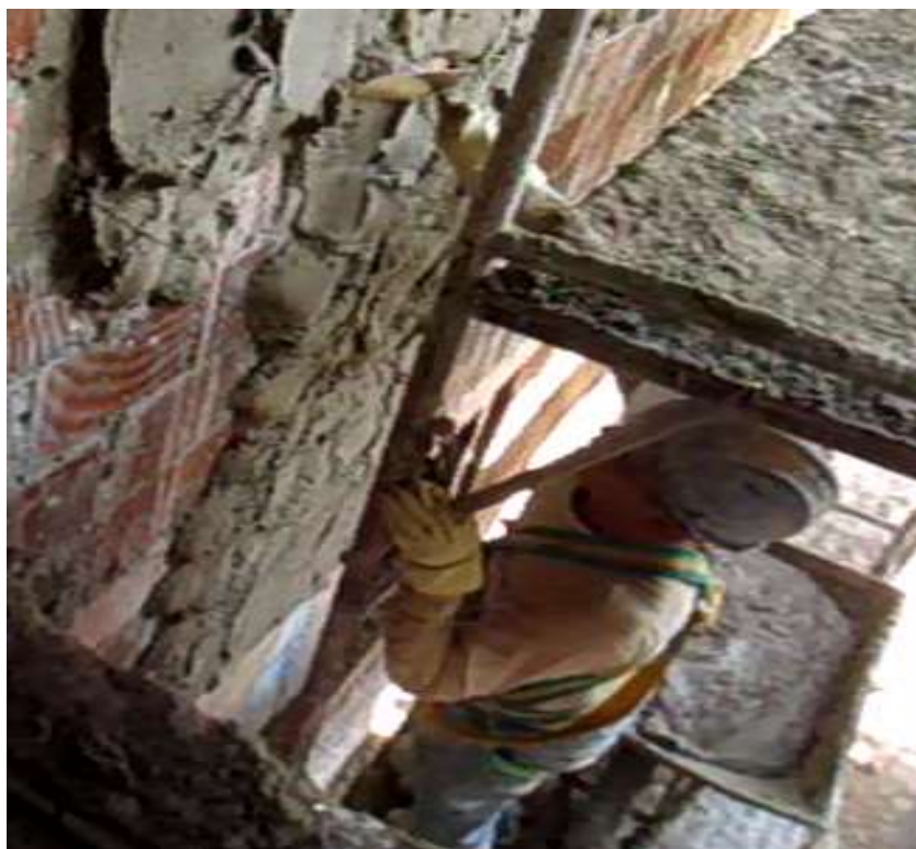
Figura 8: Revestimento pelo método tradicional.
