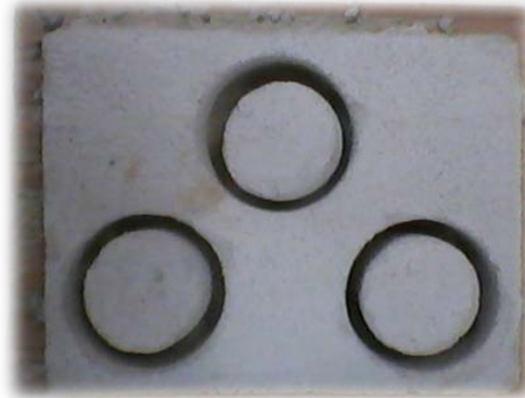
Figura 12: Furos executados para aferição da aderência.
