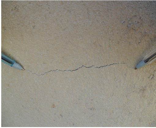
Figura 11 (a): fissuração
