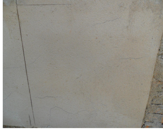
Figura 11 (b): fissuração
