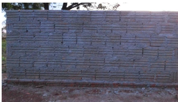
Figura 3: Base para aplicação das argamassas
