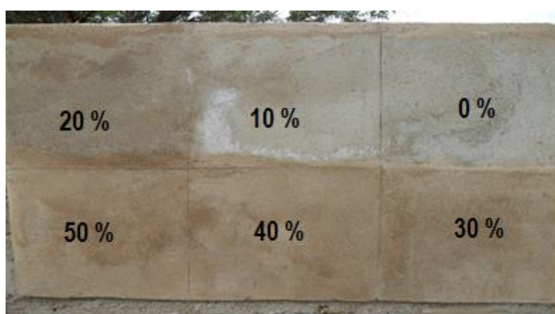
Figura 7: Argamassa já aplicada na parede
