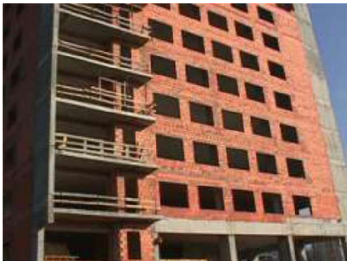
Figura 5.7 – Panos de alvenaria muito longos. Fonte: SILVA, Mendes da; ABRANTES, Vítor. 2007.
