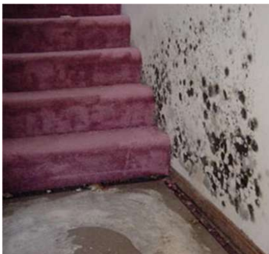
Figura 5.54 – Bolor na pintura. Fonte: http://3.bp.blogspot.com/_SMsIK9MbG4U .
