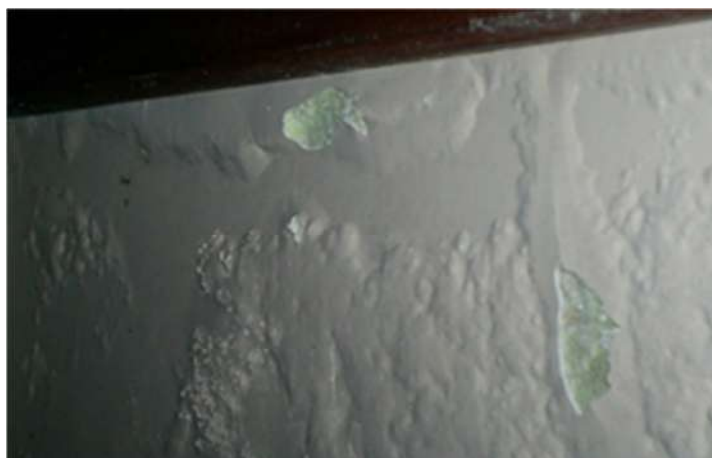
Figura 5.55 – Calcinação na pintura. Fonte: http://www.futuratintas.com.br/img/superficies/calcinacao.jpg
