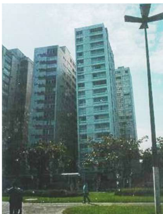
Figura 5.3 - Inclinação em edifícios em Santos – SP
