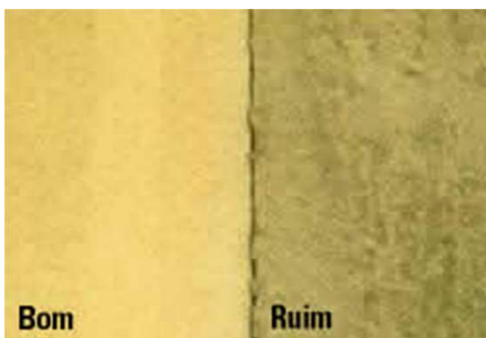
Figura 5.58 – Pintura sem encardimento e com encardimento. Fonte: http://www.pqi.com.br/sp/spe08.html .
