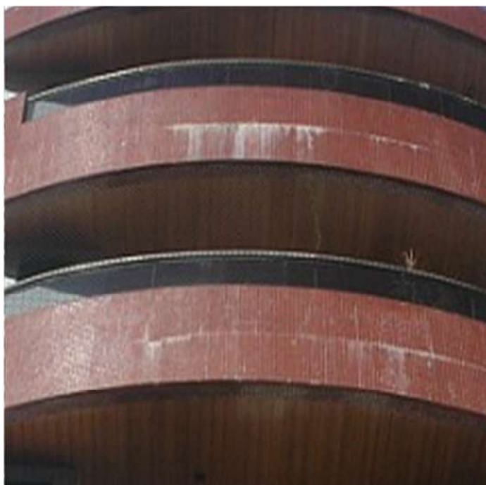
Figura 5.43 – Eflorescência nas pastilhas. Fonte: PADILHA et al. (2007).
