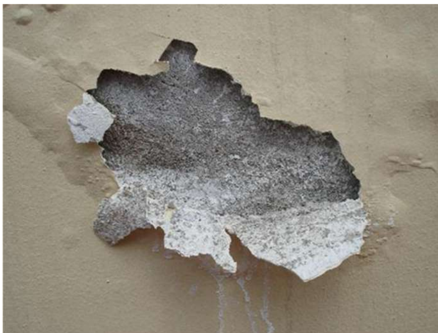
Figura 5.47 – Descolamento da pintura. Fonte: http://images01.olx.com.br/ui/8/73/16/1283973453_98276716_1-Fotos .
