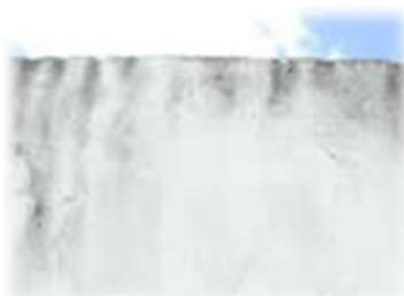
Figura 5.52 – parede sem rufo
