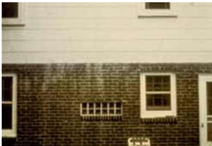
Figura 5.60 – Escorrimento da calcinação. Fonte: http://www.pqi.com.br/sp/spe10.html
