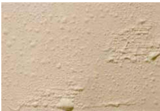
Figura 5.53 – Bolhas na pintura. Fonte: http://multicryltintas.com.br/bolhas.htm .
