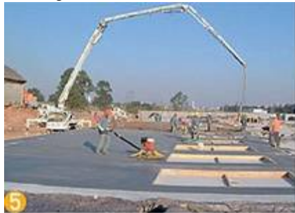
Figura 25 - Acabamento do painel
