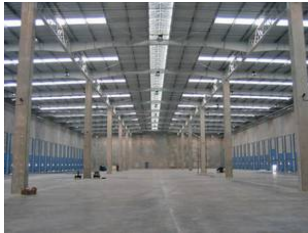
Figura 4 - Galpão executado com sistema construtivo tilt-up . Fonte: Empório do pré-moldado
