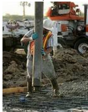
Figura 22 - Concreto usinado bombeado
