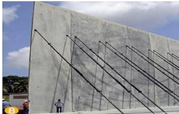
Figura 29 - Painel com escoramento metálico
