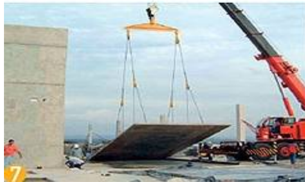
Figura 28 - Içamento do painel
