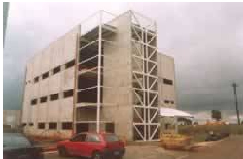
Figura 7 - Centro comercial. Integração entre dois sistemas construtivos (aço e tilt-up ). Fonte: Empório do pré-moldado
