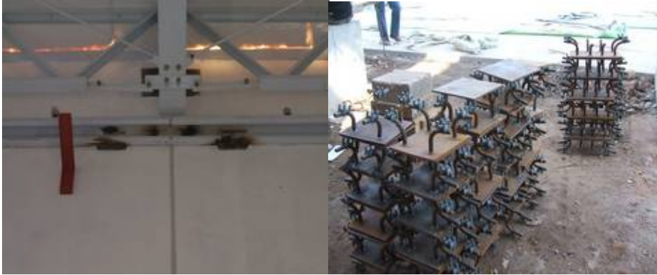
Figura 11 - Inserts para fixação com a estrutura metálica da cobertura Fonte: Wtorre engenharia e construção
