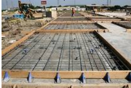
Figura 21 - Ferragem nas Formas
