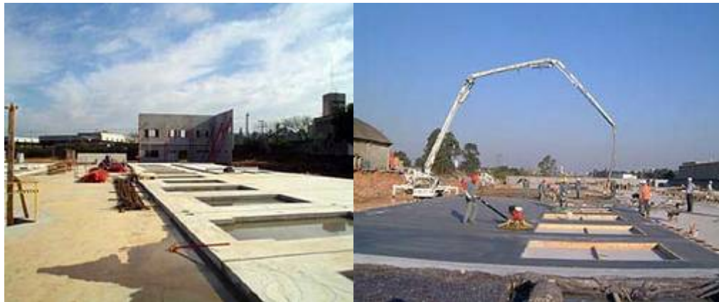
Figura 10 - Concretagem dos painéis sobre o piso. Fonte: (Construtora Diase).
