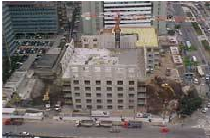
Figura 6 - Prédio com placas de tilt-up . Fonte: Infraestrutura.enge
