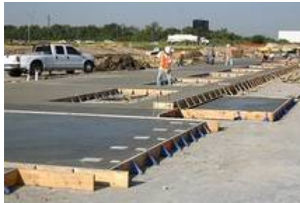
Figura 24 - Placa Concretada
