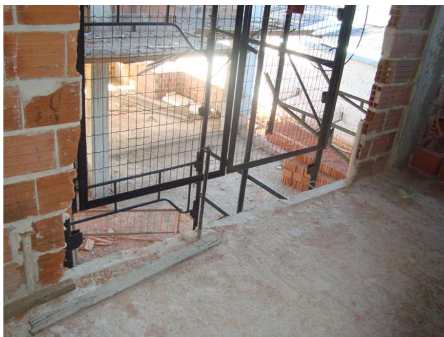
FIGURA 24 – DEMOLIÇÃO DA ALVENARIA PARA ACESSO AO ELEVADOR DE SERVIÇO (FONTE: AUTORES)
