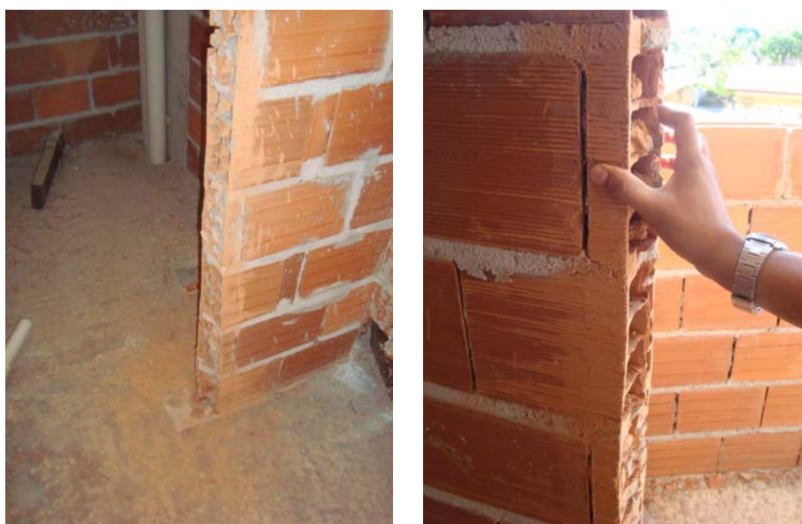
FIGURA 20 – ACABAMENTO PARA ENQUADRAMENTO DA ESQUADRIA (FONTE: AUTORES)
