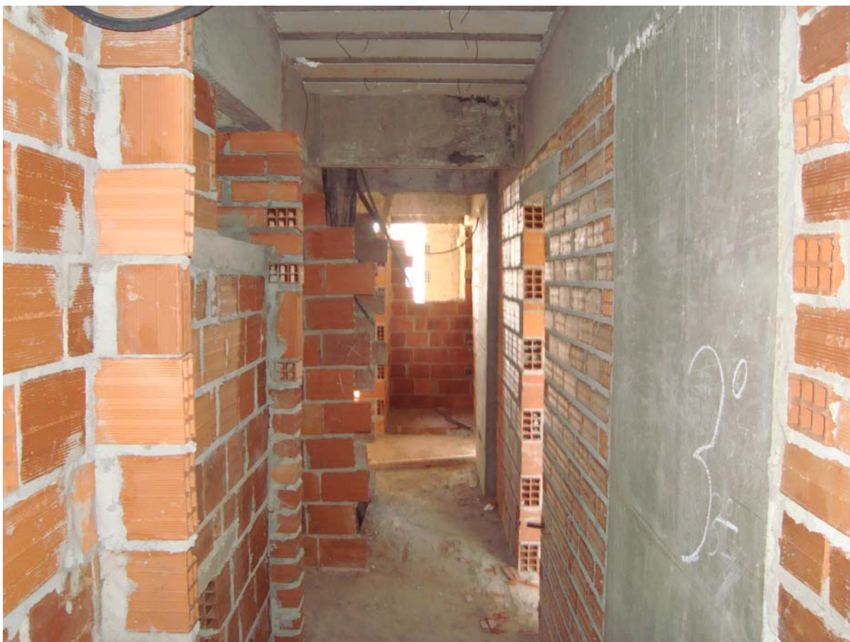
FIGURA 01 – ALVENARIA DE VEDAÇÃO (FONTE: AUTORES)
