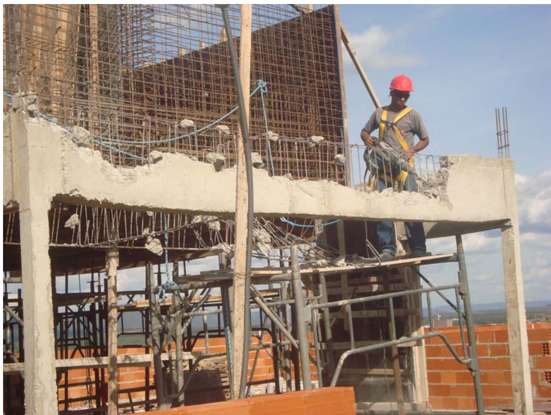
FIGURA 04 – DEMOLIÇÃO PARA REBAIXAMENTO DA ESTRUTURA (FONTE: AUTORES)
