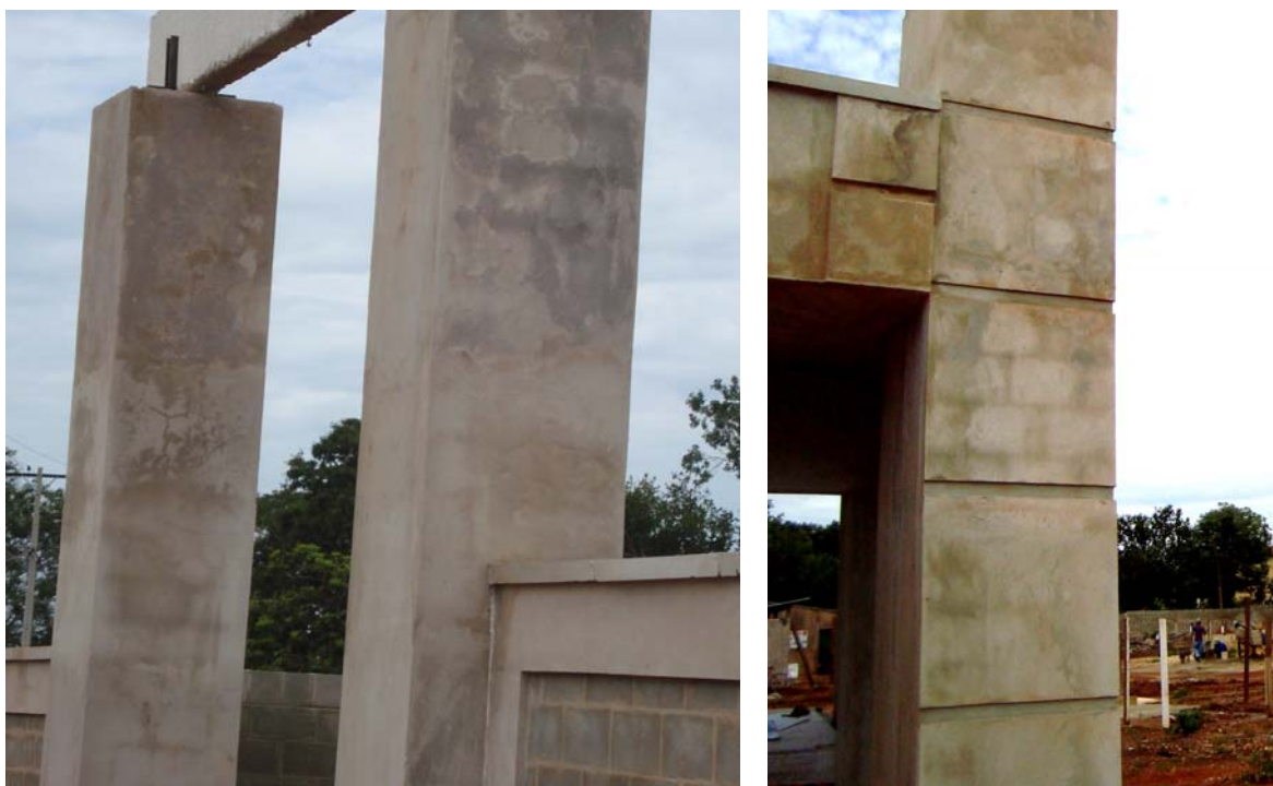
FIGURA 26 – PÓRTICO DE ACESSO (FONTE: AUTORES)
