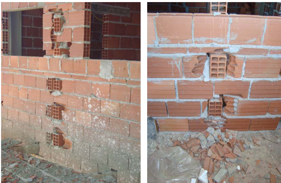
FIGURA 22 – RETRABALHO PARA AMARRAÇÃO DAS VEDAÇÕES (FONTE: AUTORES)
