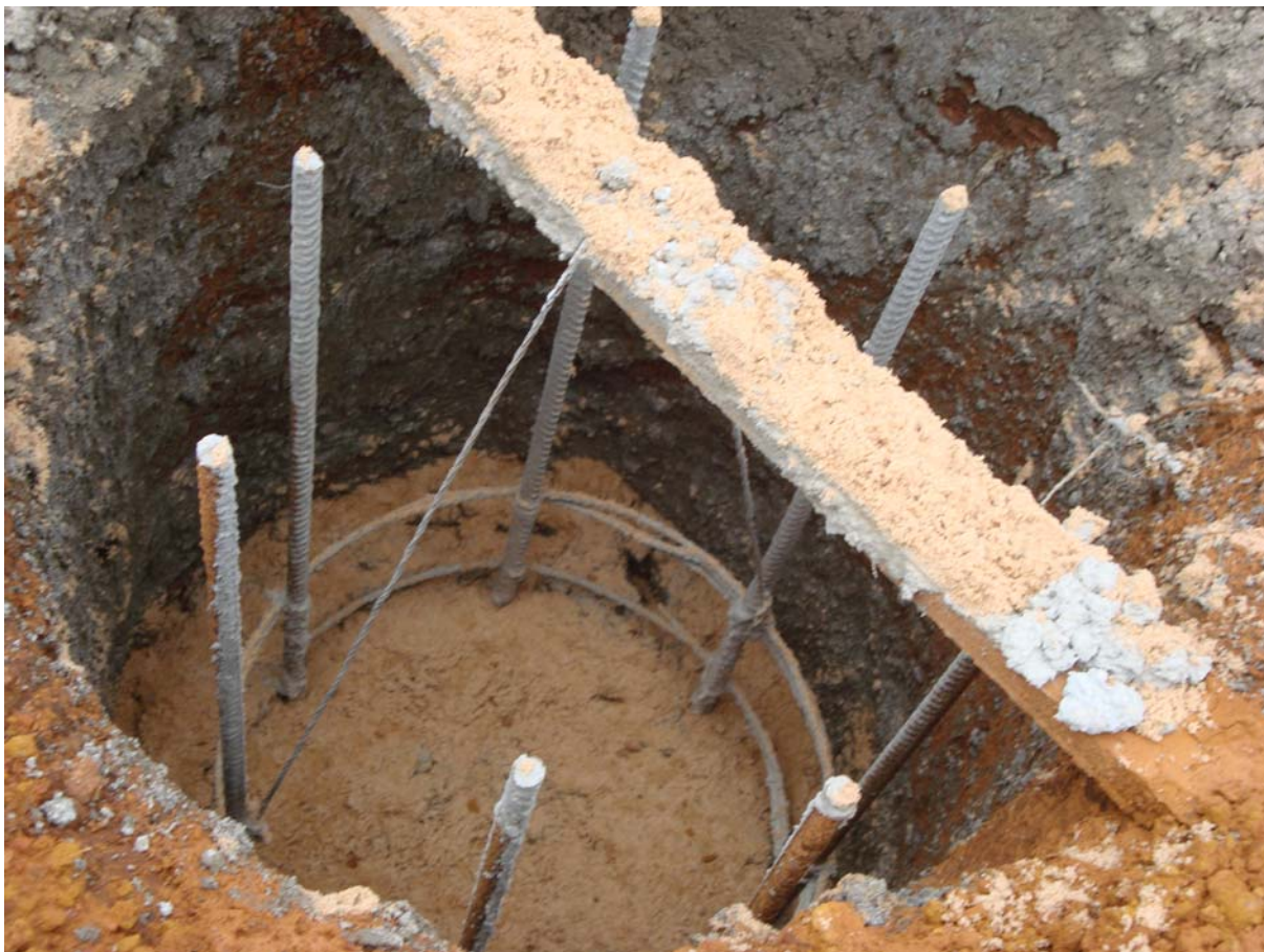
FIGURA 07 – COTA DE ARRASAMENTO DO TUBULÃO (FONTE: AUTORES)
