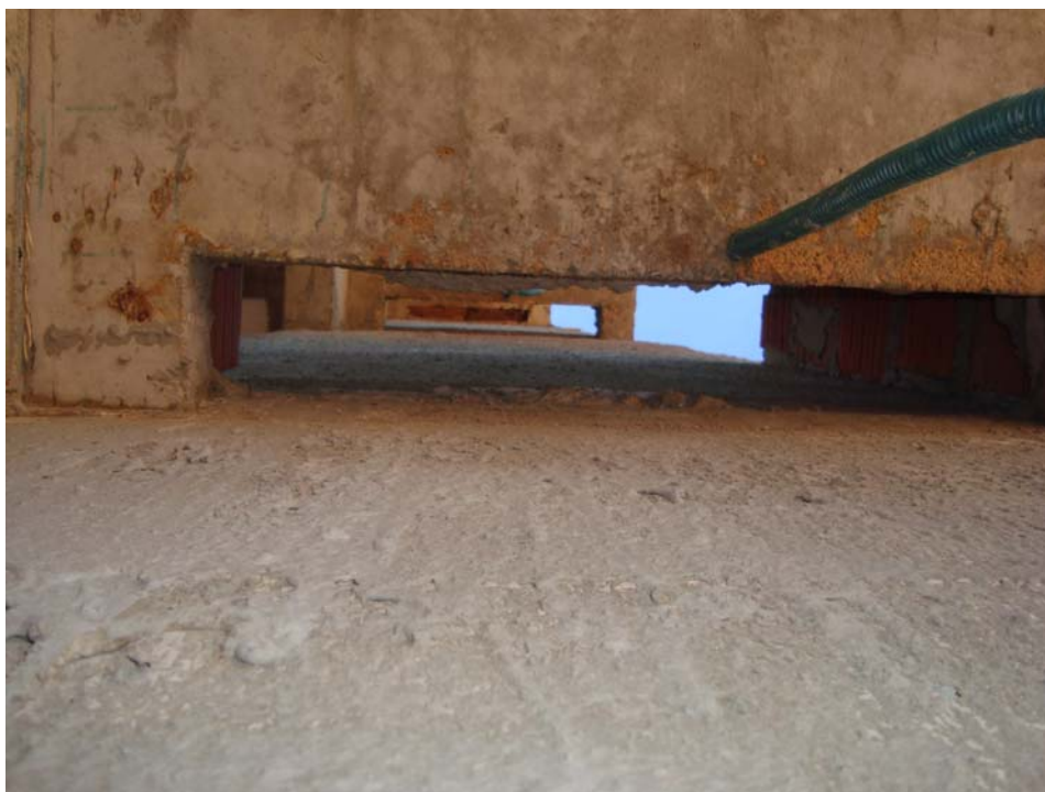
FIGURA 14 – EXECUÇÃO RACIONAL DA ESPERA DA TUBULAÇÃO DE ÁGUA FRIA. (FONTE: AUTORES)
