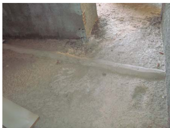
FIGURA 28 – PROTEÇÃO MECÂNICA COM ARGAMASSA DO ELETRODUTO (FONTE: AUTORES)
