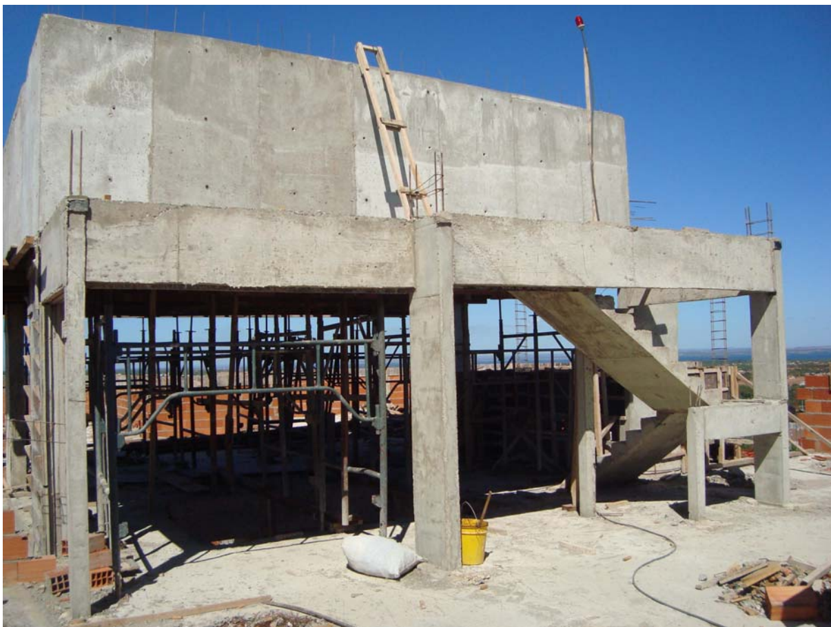
FIGURA 02 – ESTRUTURA EM CONCRETO ARMADO (FONTES AUTORES)
