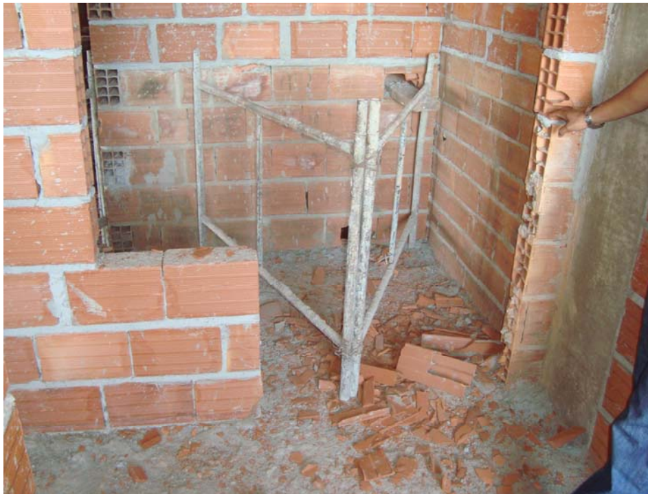
FIGURA 21 – DEMOLIÇÃO DA ALVENARIA PARA READEQUAÇÃO DO ENQUADRAMENTO DA ESQUADRIA (FONTE: AUTORES)
