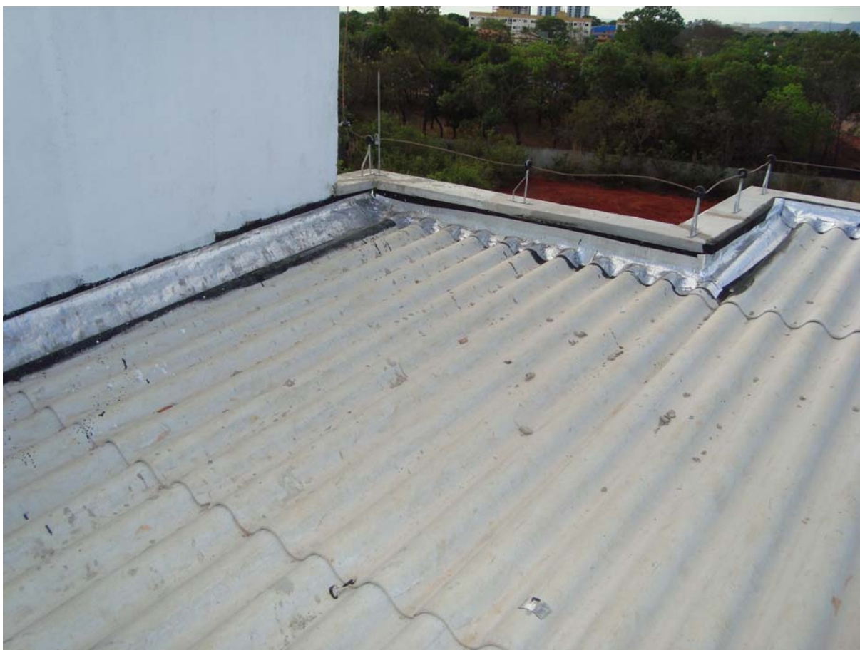
FIGURA 25 – MANTA APLICADA SOBRE A PREPARAÇÃO DA SUPERFÍCIE (FONTE: AUTORES)
