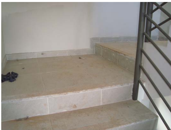
FIGURA 09 – RECONSTRUÇÃO DOS DEGRAUS (FONTE: AUTORES)
