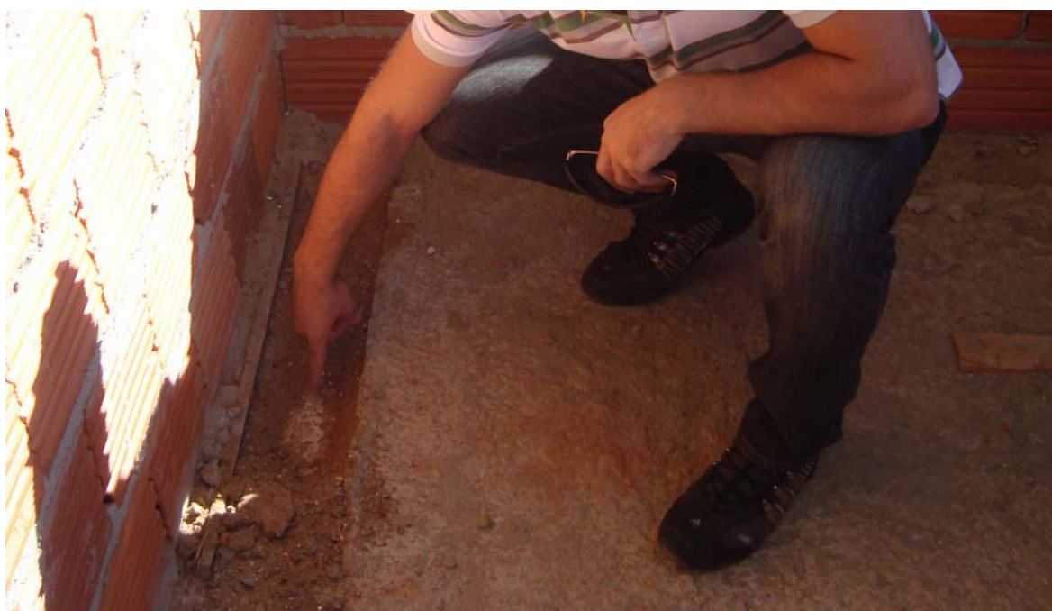
FIGURA 17 – ESPERA DA TUBULAÇÃO DE ÁGUA FRIA (FONTE: AUTORES)
