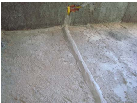
FIGURA 28 – PROTEÇÃO MECÂNICA COM ARGAMASSA DO ELETRODUTO (FONTE: AUTORES)
