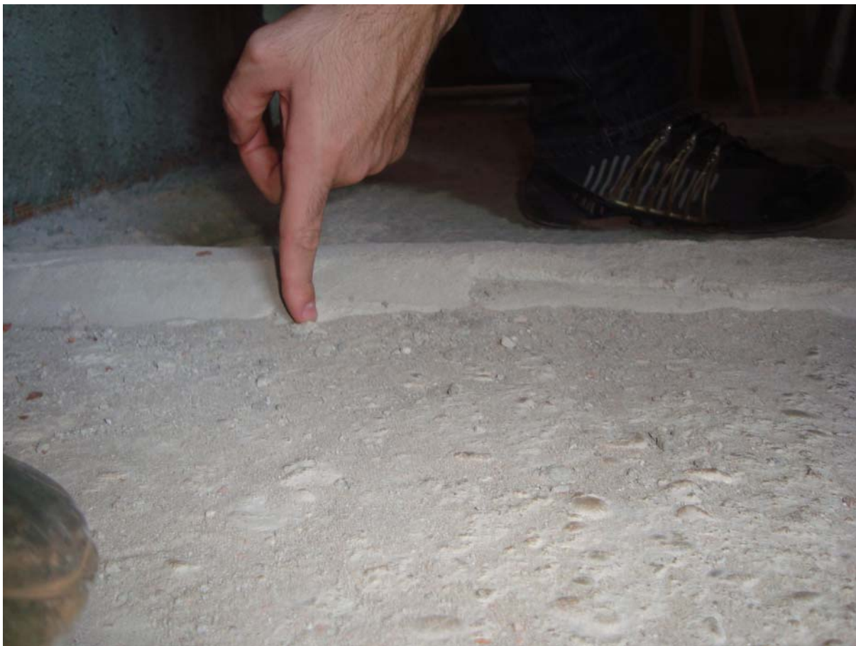
FIGURA 27 – PROTEÇÃO MECÂNICA COM ARGAMASSA DO ELETRODUTO, DETALHE (FONTE: AUTORES)
