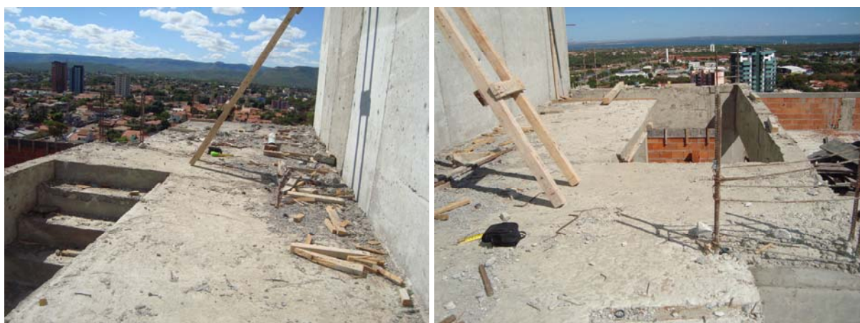
FIGURA 06 – LAJE RECONSTRUÍDA COM ESCADA DE ACESSO (FONTE: AUTORES)
