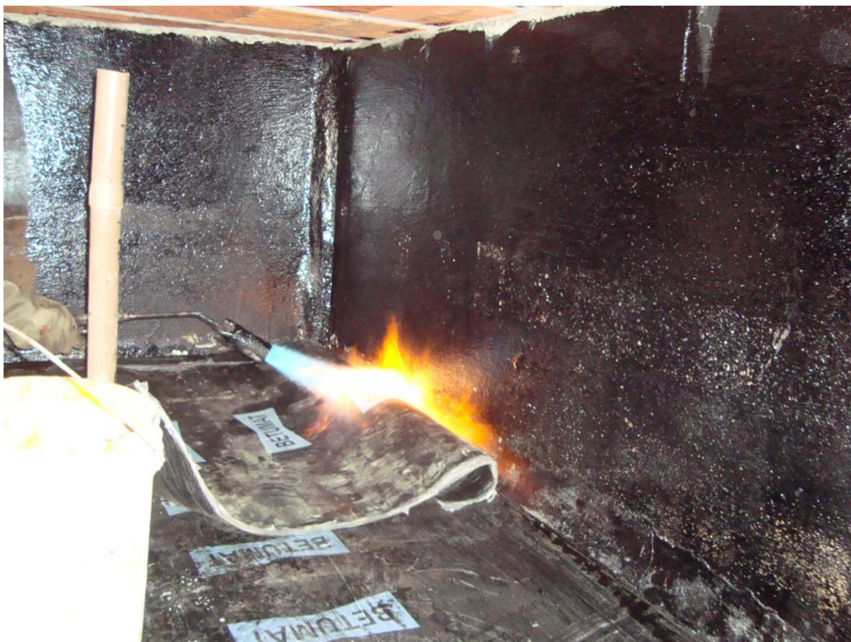
FIGURA 03 – IMPERMEABILIZAÇÃO FLEXÍVEL (FONTE: AUTORES)
