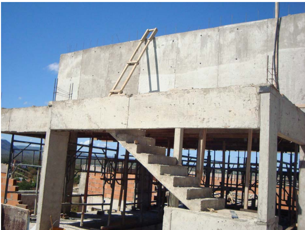
FIGURA 05 – ESTRUTURA REBAIXADA (FONTE: AUTORES)
