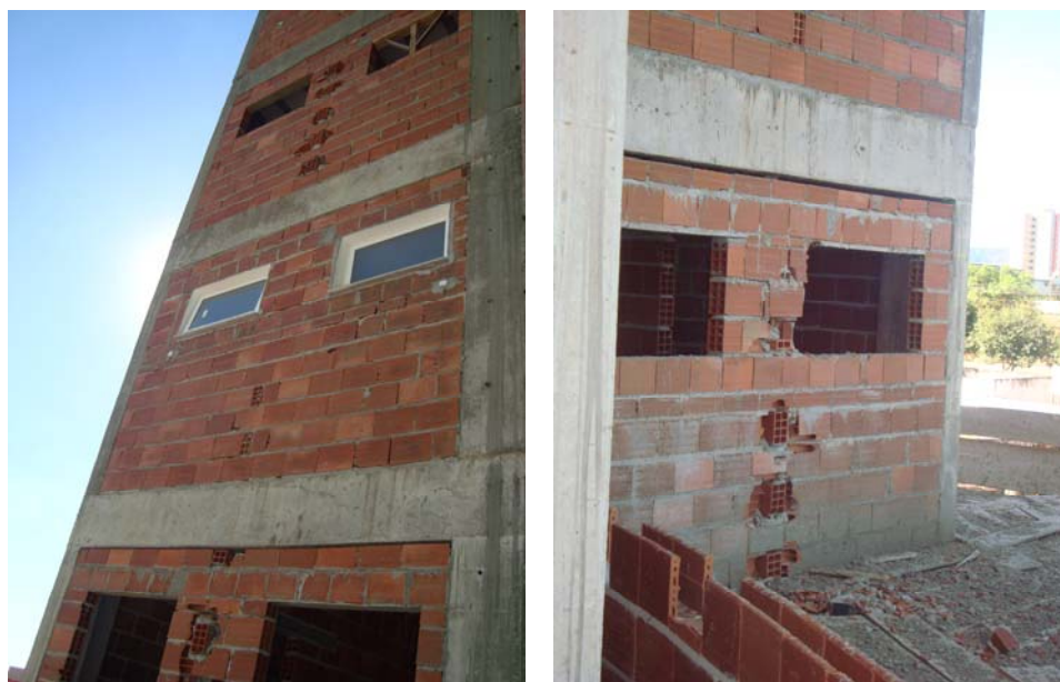
FIGURA 23 – RETRABALHO EM SÉRIE PARA AMARRAÇÃO DAS VEDAÇÕES (FONTE: AUTORES)
