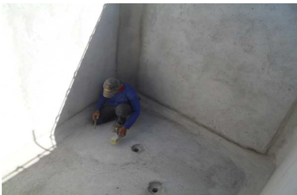
Figura 21 - Preparação da base do reservatório (Fonte: Impercia impermeabilizações)
