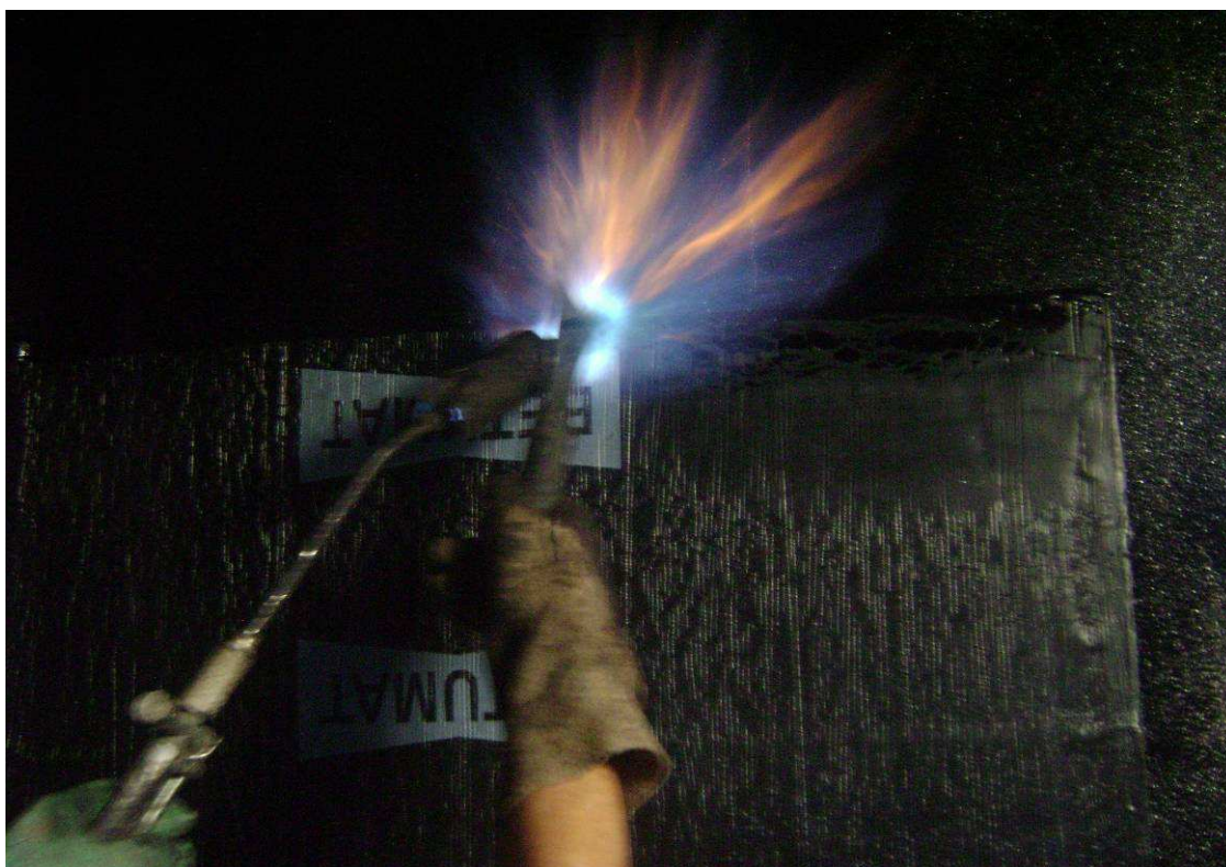
Figura 14 – Aplicação da manta asfáltica (Fonte: Autora do Projeto)
