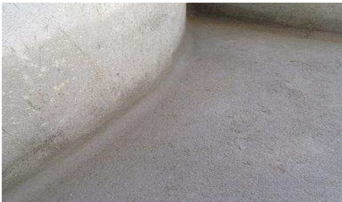
Figura 9 – Superfície Regularizada (Fonte: http://www.primer.com.br/manualdoimpermeabilizador.htm )
