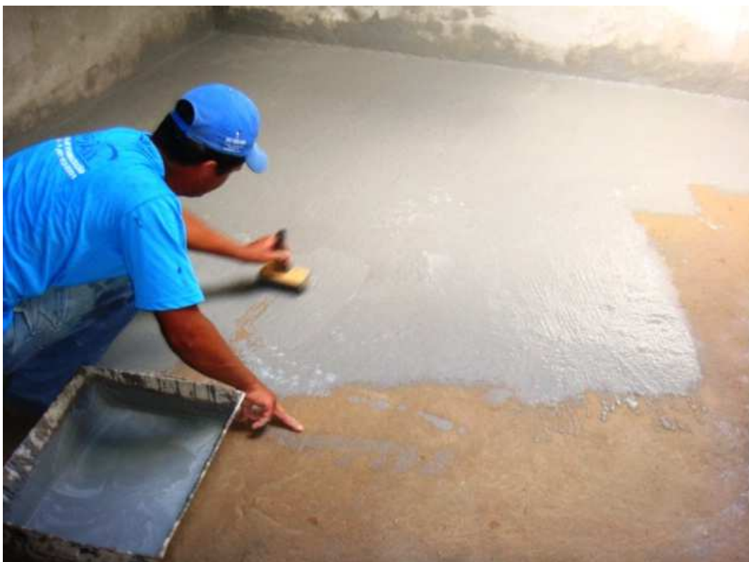
Figura 24 - Aplicação da argamassa polimerica no reservatório (Fonte: Imper Max impermeabilização).
