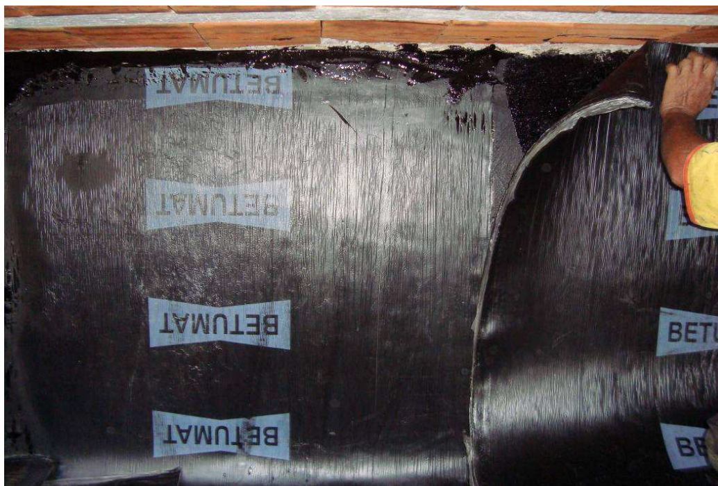
Figura 15 – Sobreposição das mantas asfálticas (Fonte: Autora do Projeto)
