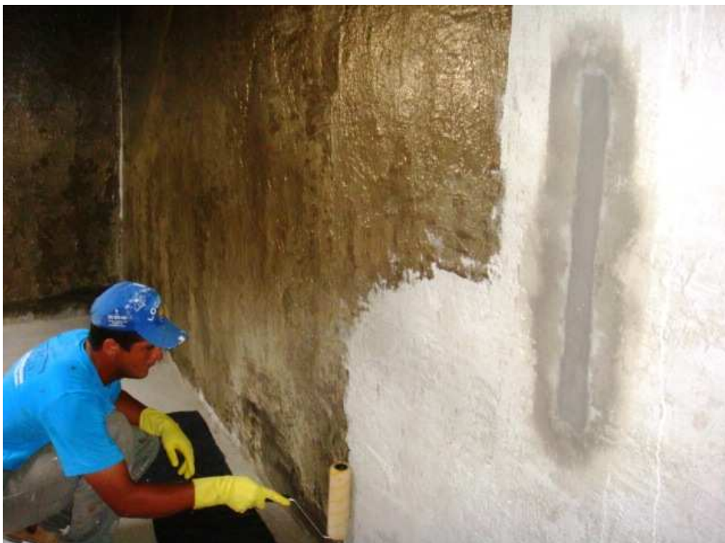
Figura 25 - Aplicação da resina poliuretana (Fonte: Imper Max impermeabilização).
