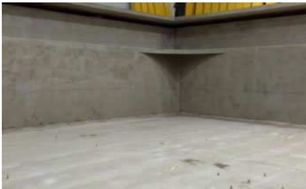
Figura 11 - Superfície regularizada para receber o processo de impermeabilização. (Fonte: www.ibisp.org.br/?pagid=vrevista_techne&id )
