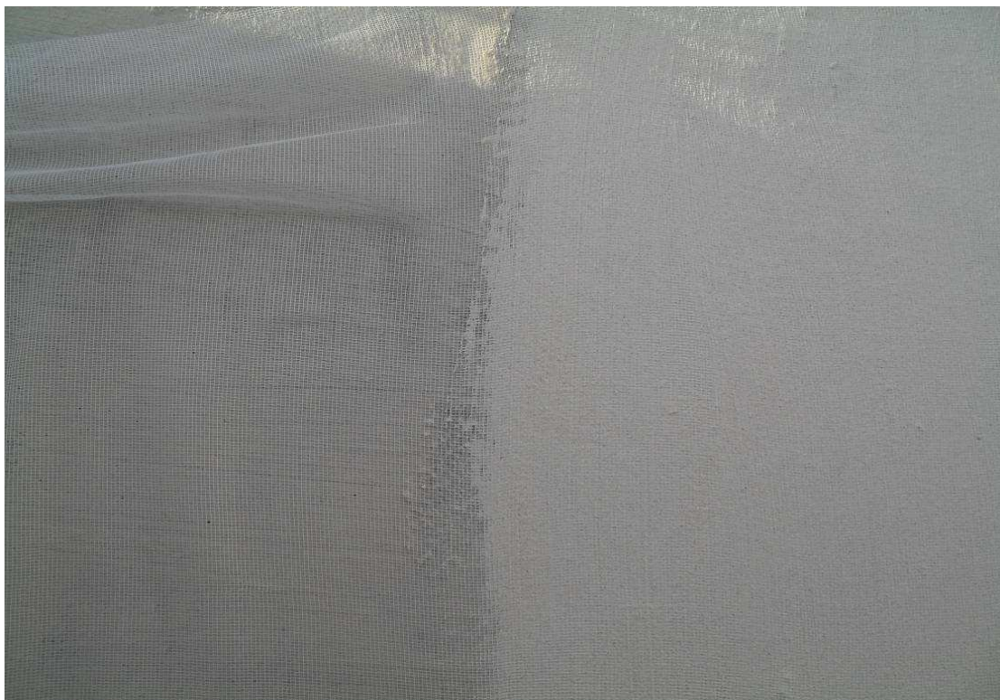
Figura 23 - Aplicação da tela Poliéster após a primeira demão do elastomérico (Fonte: Impercia impermeabilizações.)
