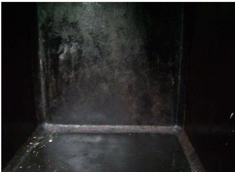
Figura 12 - Reservatório com a aplicação do primer (Fonte: Autora do Projeto)
