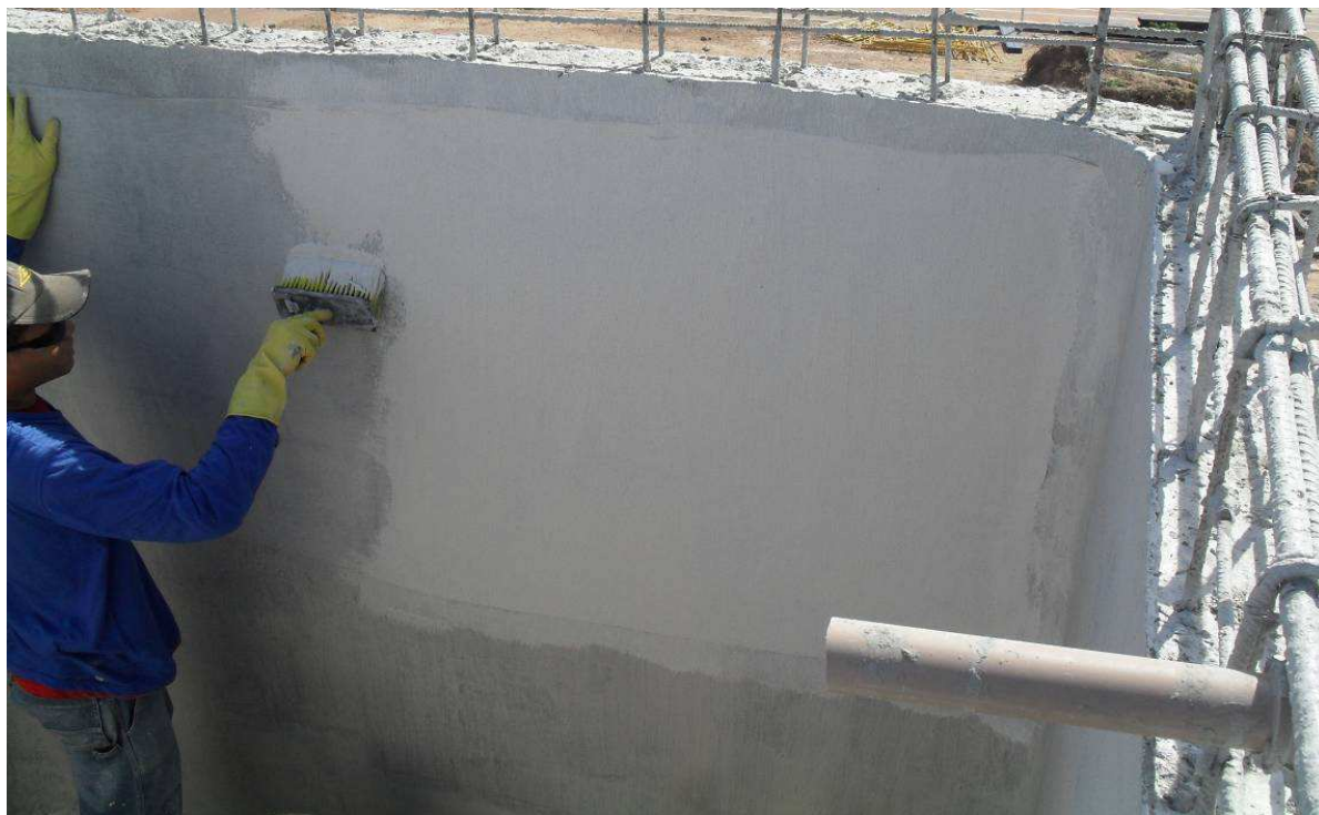
Figura 22 - Aplicação de argamassa elastomérica com o uso de trincha no reservatório elevado (Fonte: Impercia impermeabilizações)
