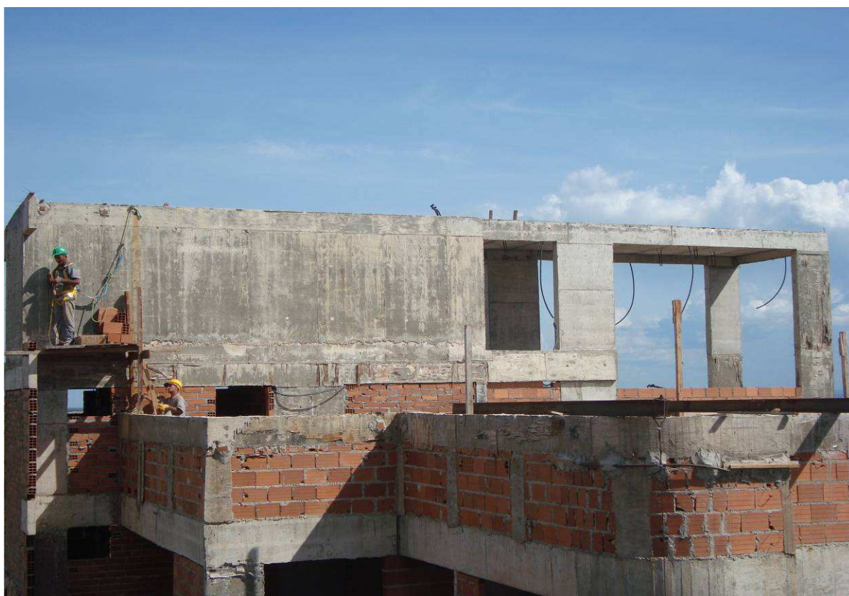
Figura 3 - Reservatório Elevado de Concreto (Fonte: Autora do Projeto)
