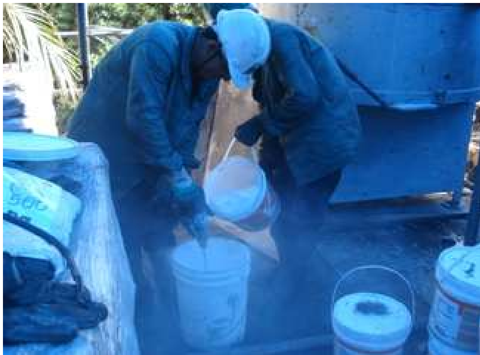
Figura 20 - Mistura do elastomérico com o uso de hélice de aço na furadeira elétrica (Fonte: Impercia impermeabilizações)
