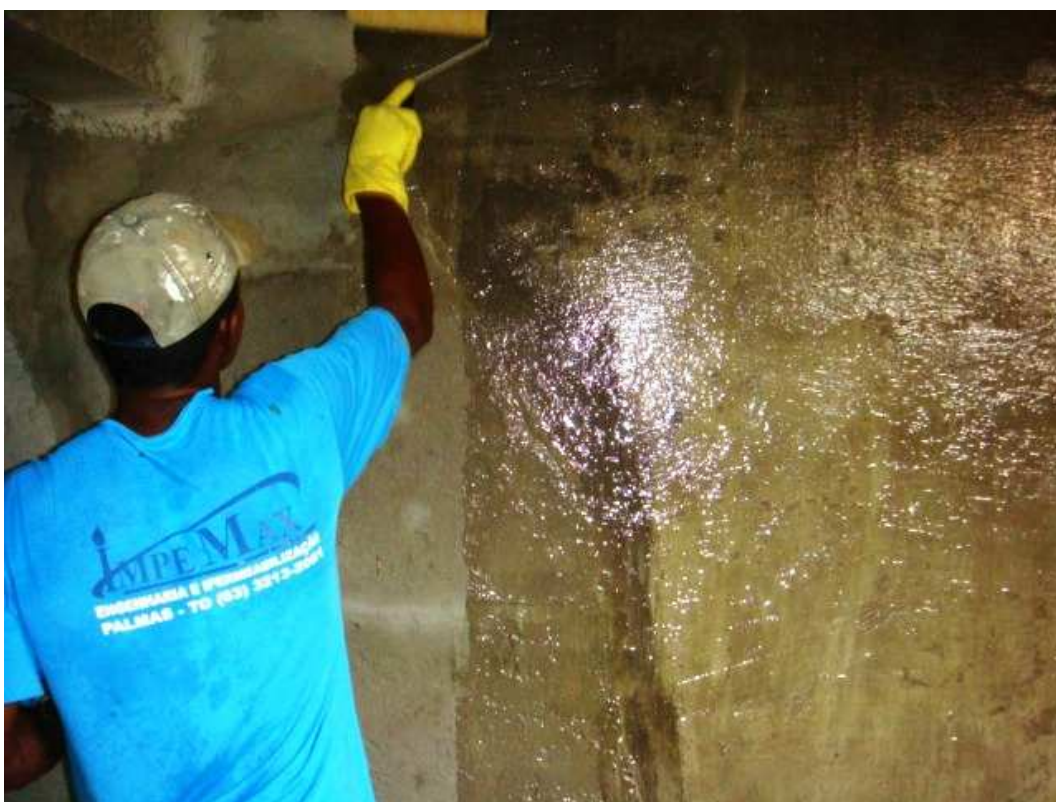
Figura 26 - Aplicação da resina poliuretana (Fonte: Imper Max impermeabilização).
