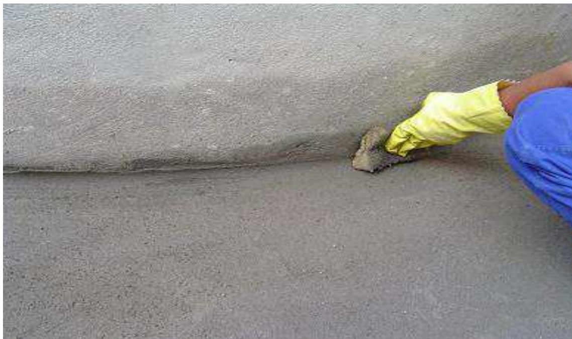
Figura 8 - Preparação da superfície para receber a impermeabilização (Fonte: http://www.primer.com.br/manualdoimpermeabilizador.htm )
