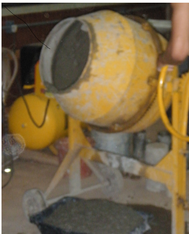
Figura 8: Mistura dos Materiais na Betoneira Fonte: Autores.
