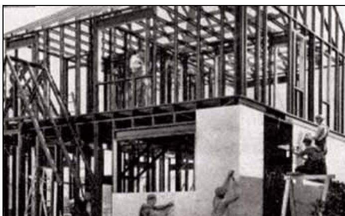
Figura 2: Protótipo de residência em Light Steel Framing na Exposição Mundial de Chicago em 1933 (Fonte: CRASTO; FREITAS, 2006)
