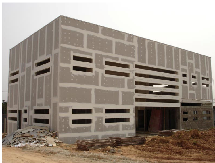
Figura 10: Fechamento com placas cimentícias (Fonte: Brasiplac - Brasilit).
