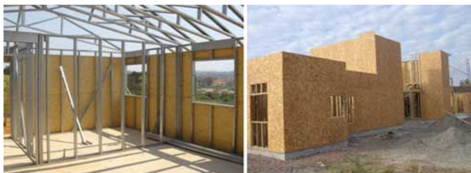
Figura 12: Fechamento com placas OSB (Fonte: LpBrasil).
