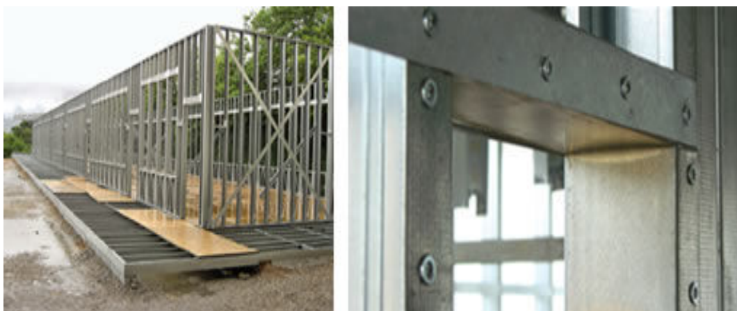
Figura 9: Instalação dos painéis verticais e detalhe de abertura (Fonte: Revista Técnica, 137).
