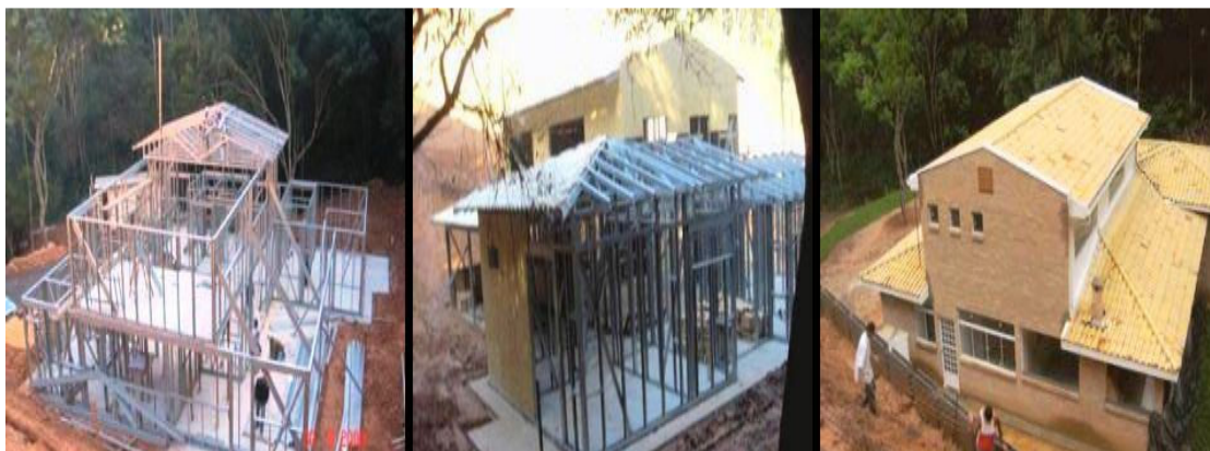
Figura 1: Residência construída com o LSF no Residencial Capital Ville (Fonte: CONSTRUTORA SEQUÊNCIA, 2008)
