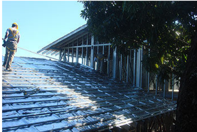
Figura 30: cobertura – aplicação de manta de subcobertura (Fonte: Revista AU)
