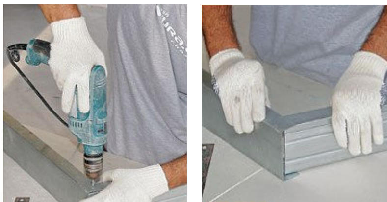
Figura 7: Montagem dos perfis (Fonte: Revista Equipe de Obra, 17).
