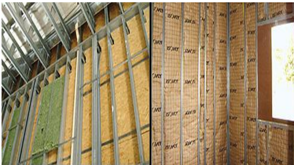
Figura 23: Colocação das mantas isolantes no interior das paredes (Fonte: Revista Técnica, 139)
