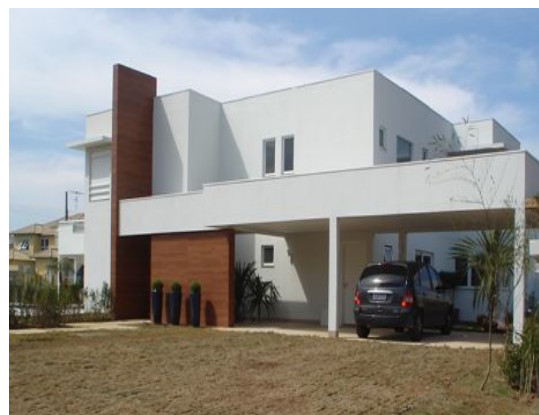
Figura 36: Residência em Aldeia da Serra – SP (Fonte: Brasiplac - Brasilit)
