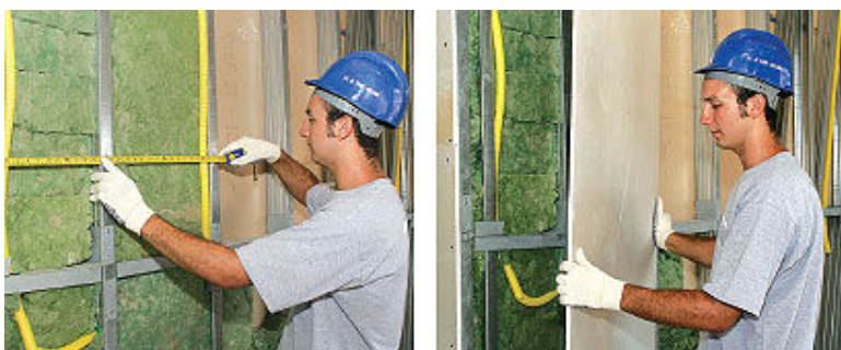
Figura 24: instalação elétrica (Fonte: Revista Equipe de Obra, 19).
