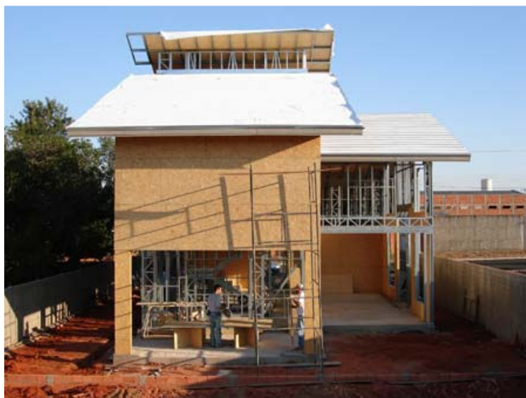
Figura 11: Fechamento com placas OSB (Fonte: Brasiplac - Brasilit).
