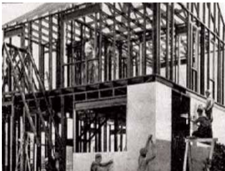
Figura 2: Protótipo de residência em Light Steel Framing na Exposição Mundial de Chicago em 1933 (Fonte: CRASTO; FREITAS, 2006)
