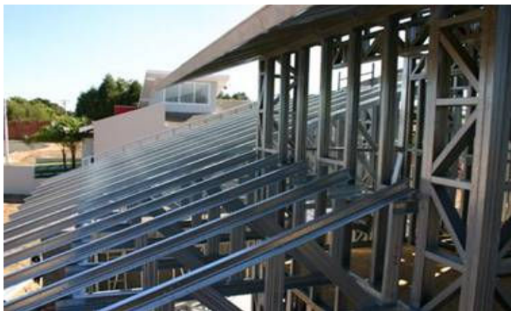
Figura 29: estrutura da cobertura (Fonte: Brasiplac – Brasilit)
