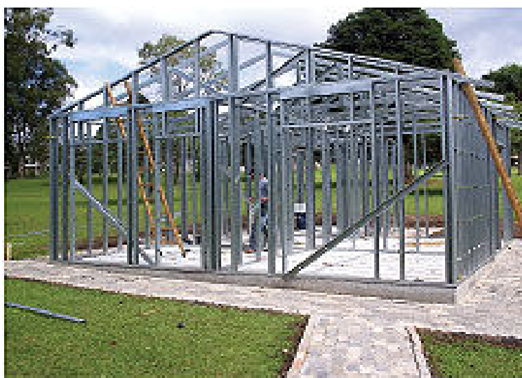
Figura 3: Estrutura em steel framing (Fonte: Revista Técnica, 135)
