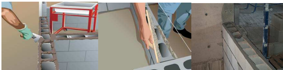
Figura 28: Aplicação da junta de argamassa de assentamento horizontal e vertical.
