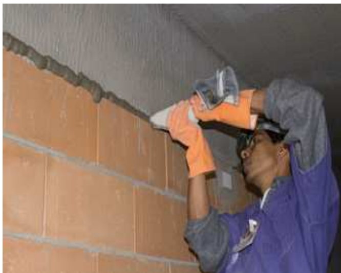
Figura 30: Execução do encunhamento. Fonte: Técnica 103 – out. 2005.
