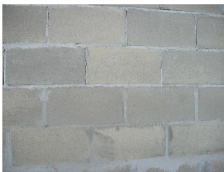
Figura 27: Juntas horizontais e verticais com 1 cm de espessura.
