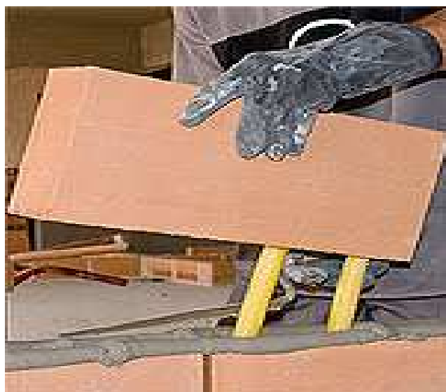
Figura 13: Passagem do eletroduto. Fonte: Juliana Nakamura, 2008.
