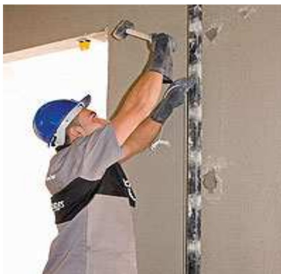
Figura 4: Fixação do escantilhão. Fonte: Juliana Nakamura, 2008.
