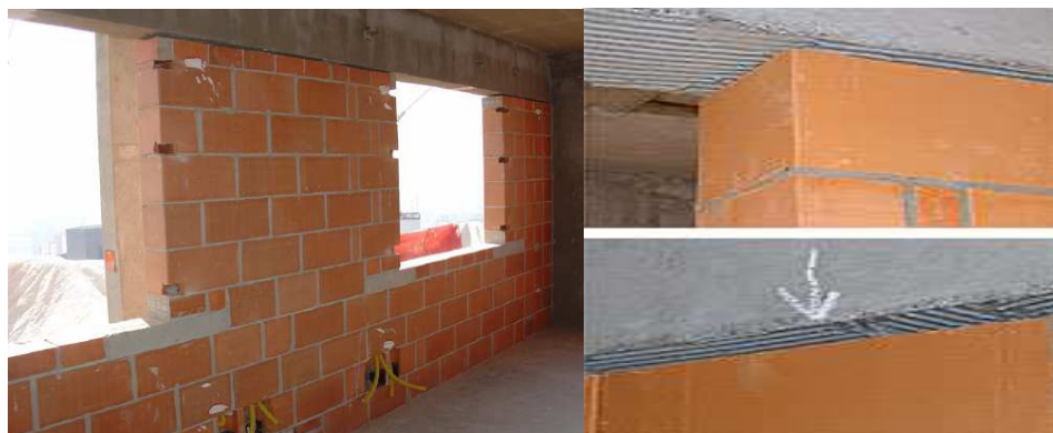
Figura 22: Encunhamento. Fonte: Nakamura, 2007.
