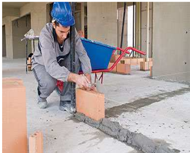
Figura 10: Colocação da linha. Fonte: Juliana Nakamura, 2008.
