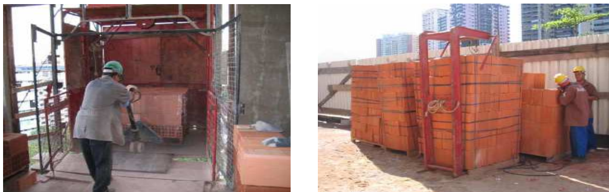
Figura 41: Transporte dos blocos paletizados.
