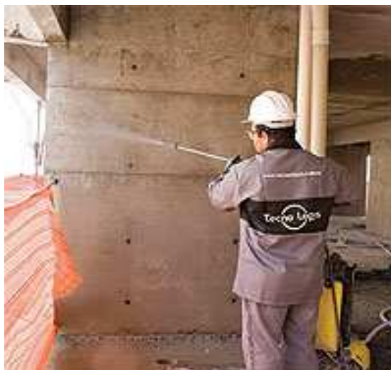
Figura 3: Limpeza da estrutura. Fonte: Juliana Nakamura, 2008.
