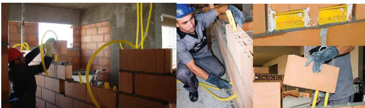
Figura 20: Passagem dos eletrodutos e fixação das caixinhas elétricas.
