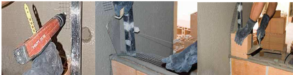
Figura 18: Amarração da alvenaria com o pilar utilizando tela metálica.
