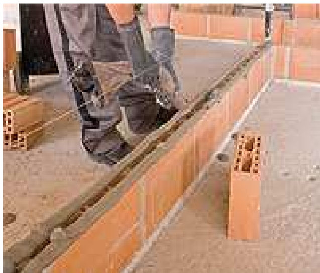
Figura 12: Junta de argamassa. Fonte: Juliana Nakamura, 2008.
