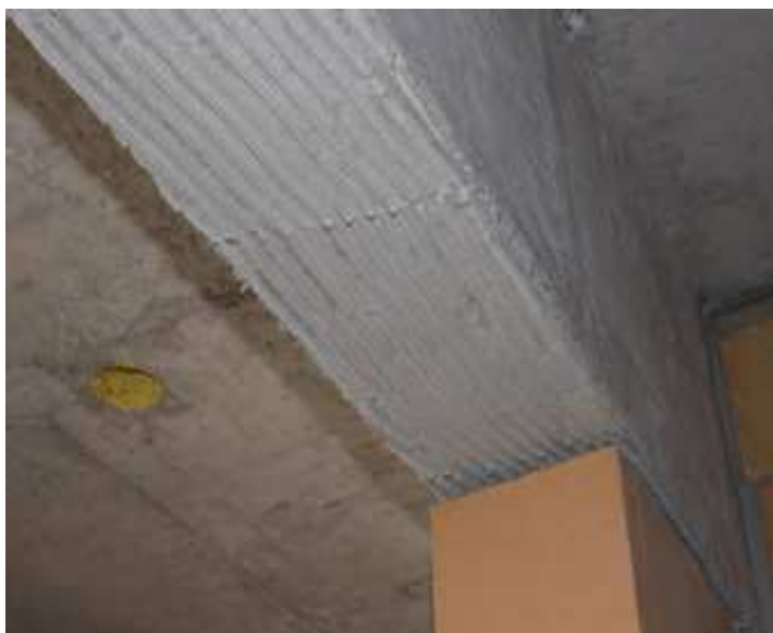
Figura 29: Preparação do fundo da viga.
