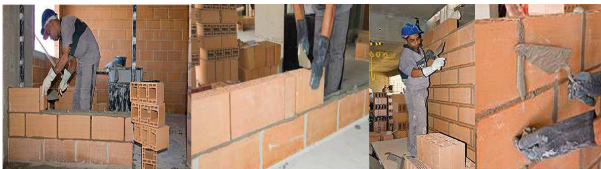
Figura 19: Assentamento dos blocos.
