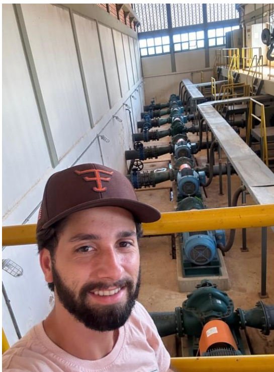
Imagem 8. Sistema de bombas do Distrito Manuel Alves.
