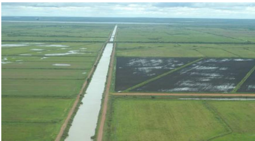
Imagem 4. Infraestrutura de Drenagem do Rio Formoso
