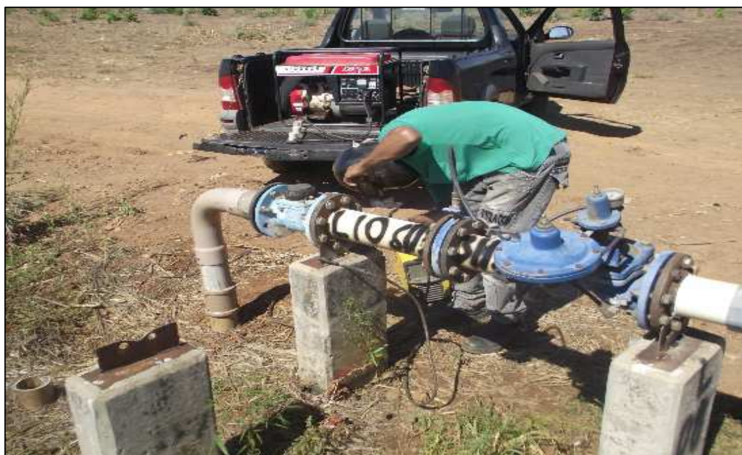
Manutenção cavaletes de água.
