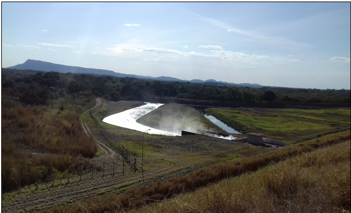
Barragem do Projeto Manuel Alves
