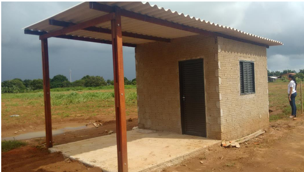
Figura 11: Galpão particular para armazenagem de embalagens.
