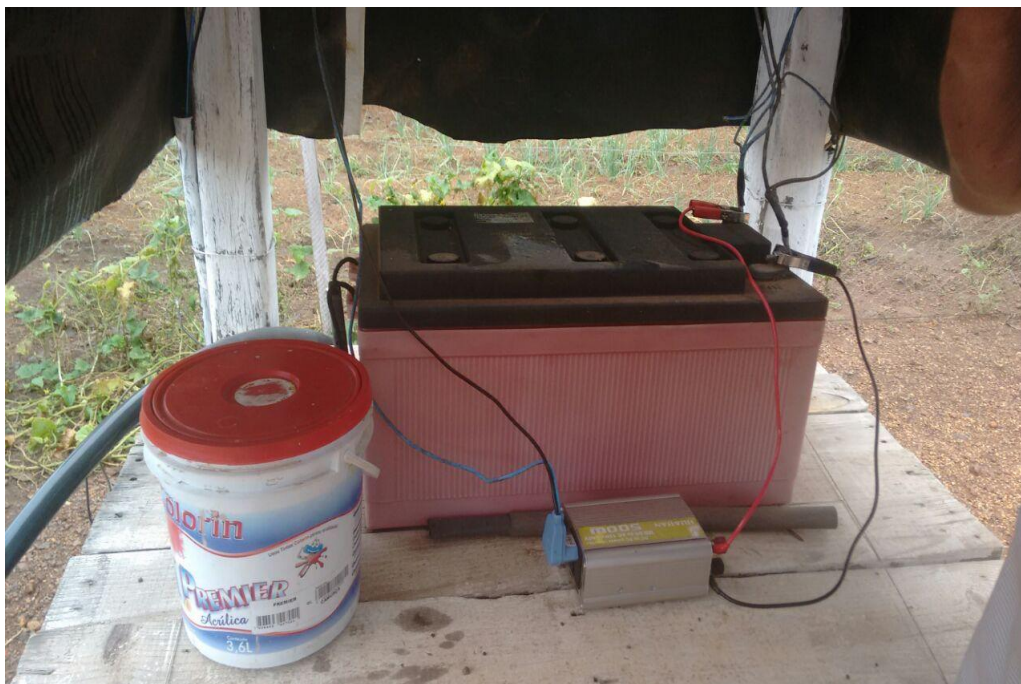
FOTO 3: Sistema de armazenamento e distribuição da energia solar
