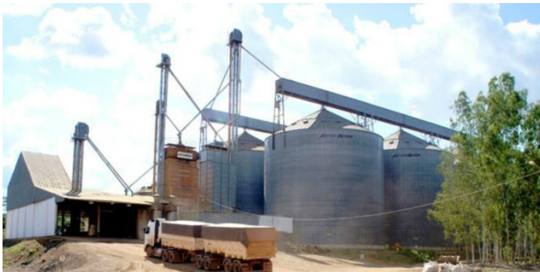
Imagem 1. Silo de armazenamento de grãos da COAPA
