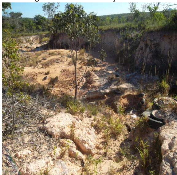
Fig.22 – Extensão da Voçoroca
