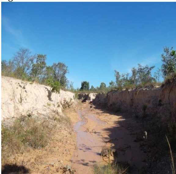
Fig.21 – Extensão da Voçoroca
