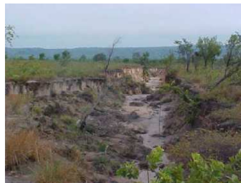
Fig. 4. Fase de avanço da voçoroca
