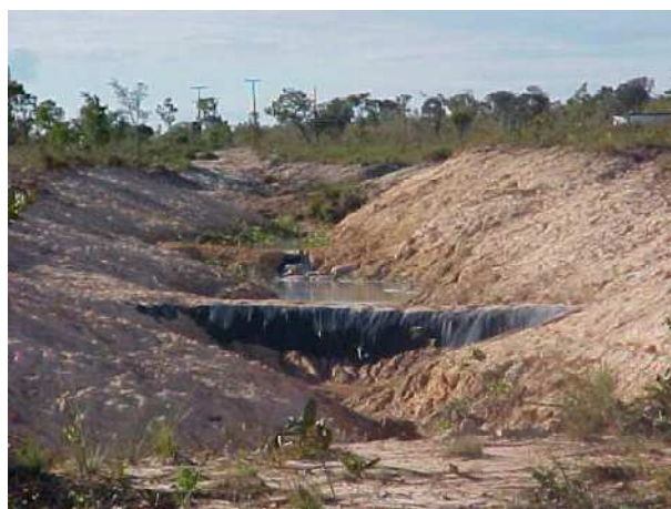
Fig.18 - Conclusão da primeira barragem
