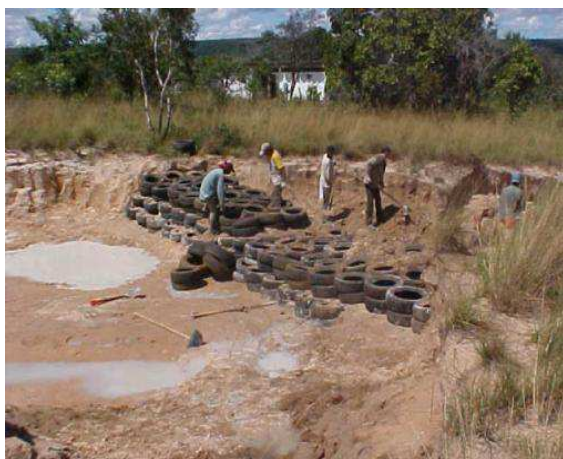
Fig. 17 - Montagem das barragens
