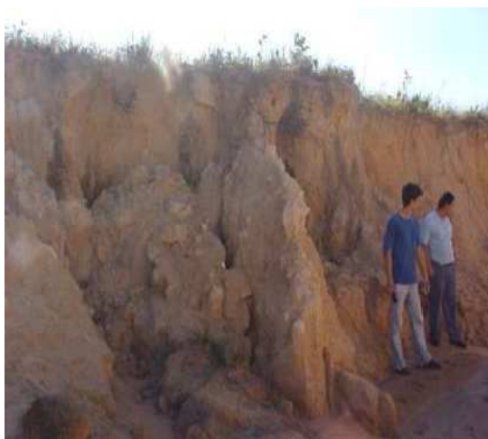
Fig. 13 – Antes; Altura dos barrancos
