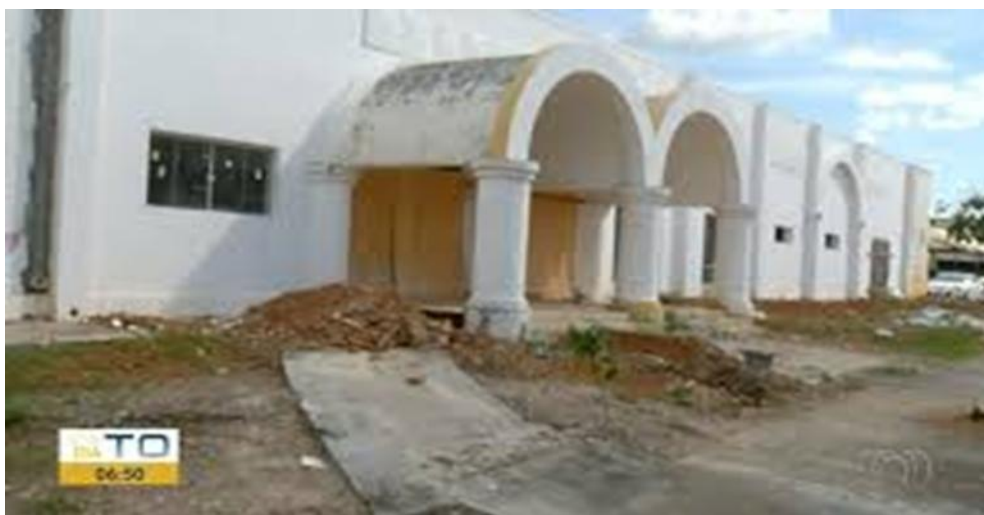
Figura 8 – Centro Cultural em obras para revitalização
