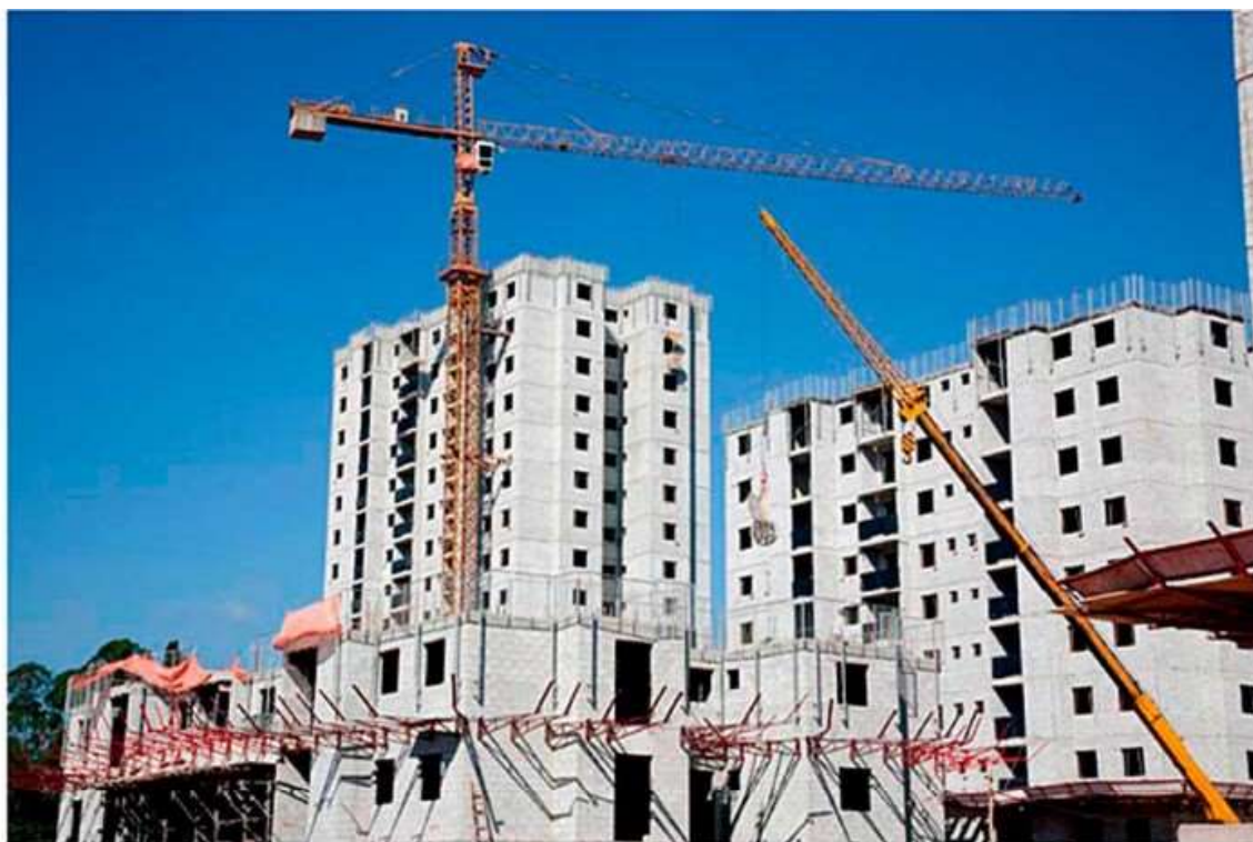
Figura 1: Alvenaria estrutural com blocos de concreto.
