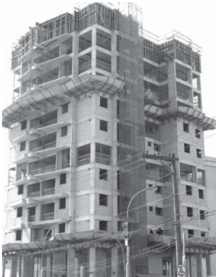
Figura 2: Construção de edifício utilizando alvenaria de vedação.
