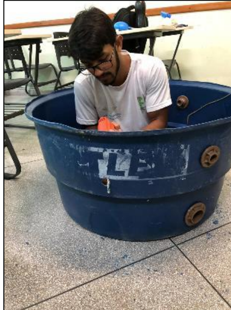
Figura 17 – Instalação do Componentes.
