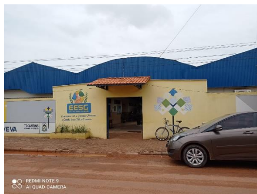
Imagem 1 - Fachada da Escola Estadual Santa Geneveva
