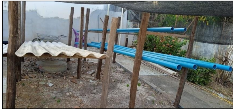
Figura 2 – Construção das bancadas
