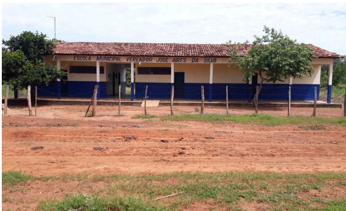
Figura 01: Escola da Comunidade Quilombola de Morro de São João. Fonte: Imagem do autor
